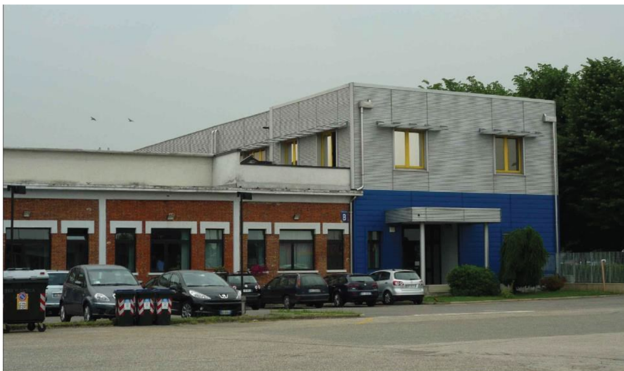
Figura 6: PEC ZUT 3.1 Michelin S.p.A. – Stato di fatto aree ante operazioni di demolizione - Edifici ad uso uffici
