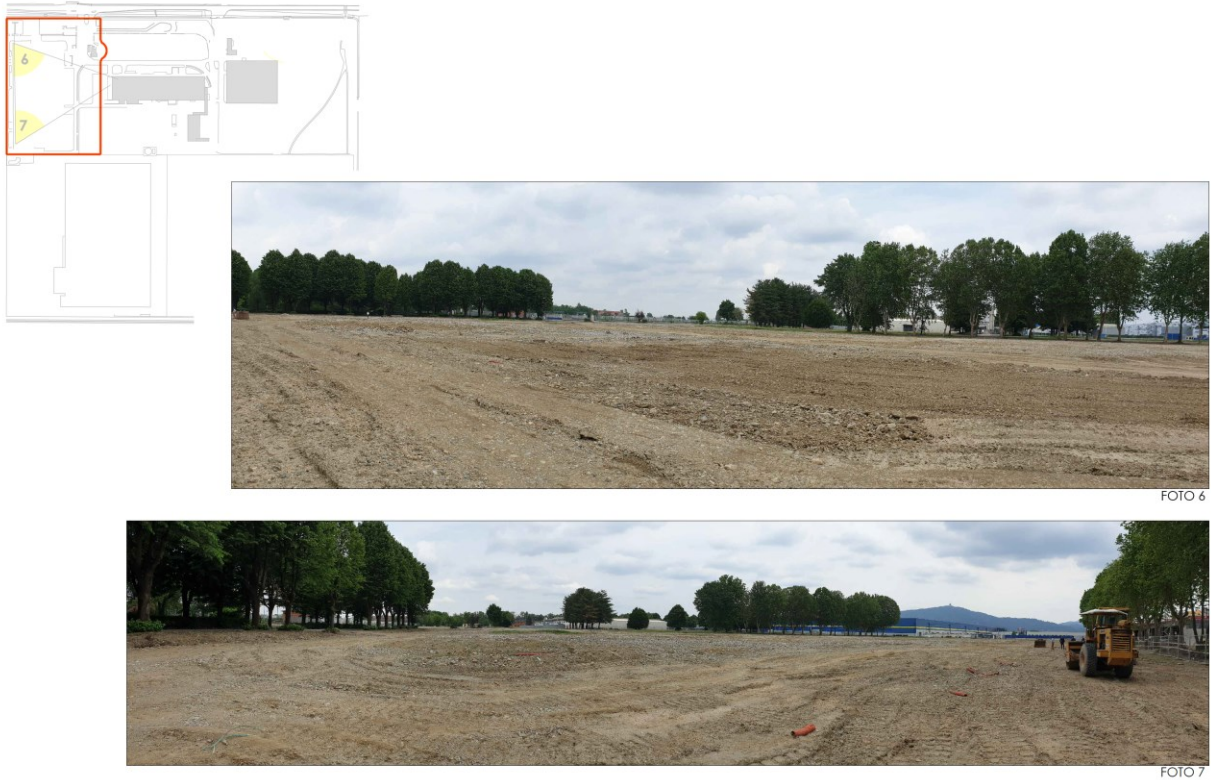
Figura 9: Stato di fatto aree post operazioni di demolizione
