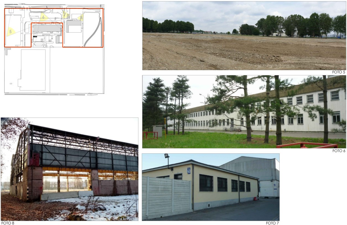
Figura 10: Stato di fatto aree post operazioni di demolizione
