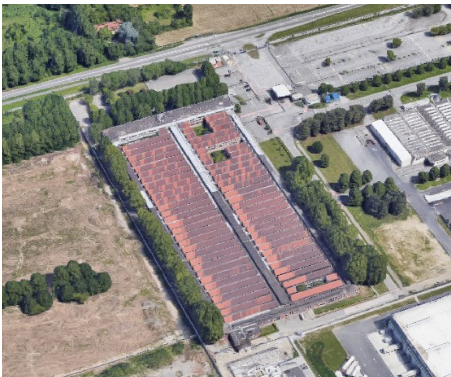
Vista aerea di dettaglio Sub Ambito 2
