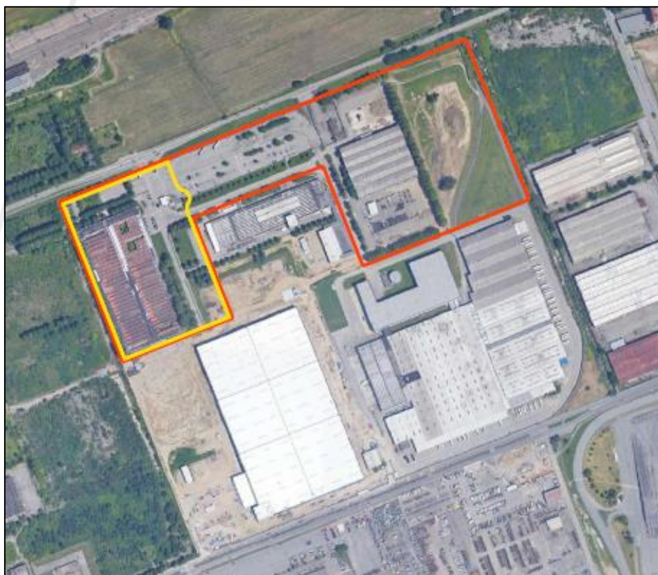
Figura 2.1 – vista aerea dello stabilimento Michelin Torino Stura con perimetrazione in rosso dell’Ambito 3.1 “Michelin”. Con perimetrazione gialla è identificato il PEC Sub-Ambito 2 in esame
