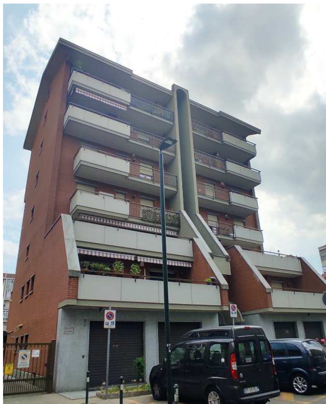
Condominio a 7 piani f.t. di via Martino Spanzotti n. 11
