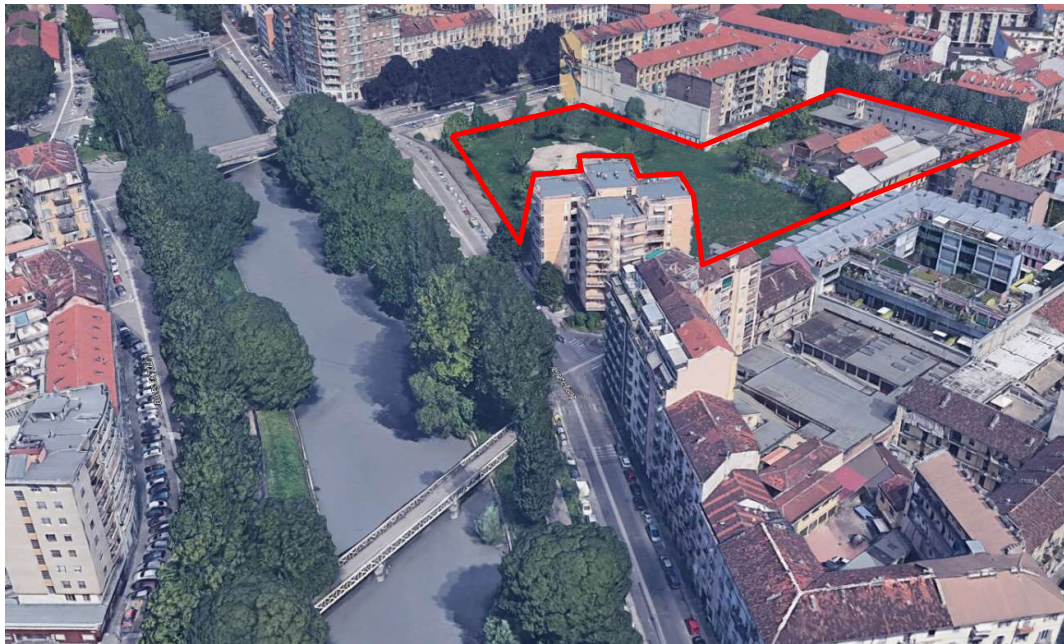
Figura 2.2: Localizzazione dell'area di intervento - veduta da Sud-Est
