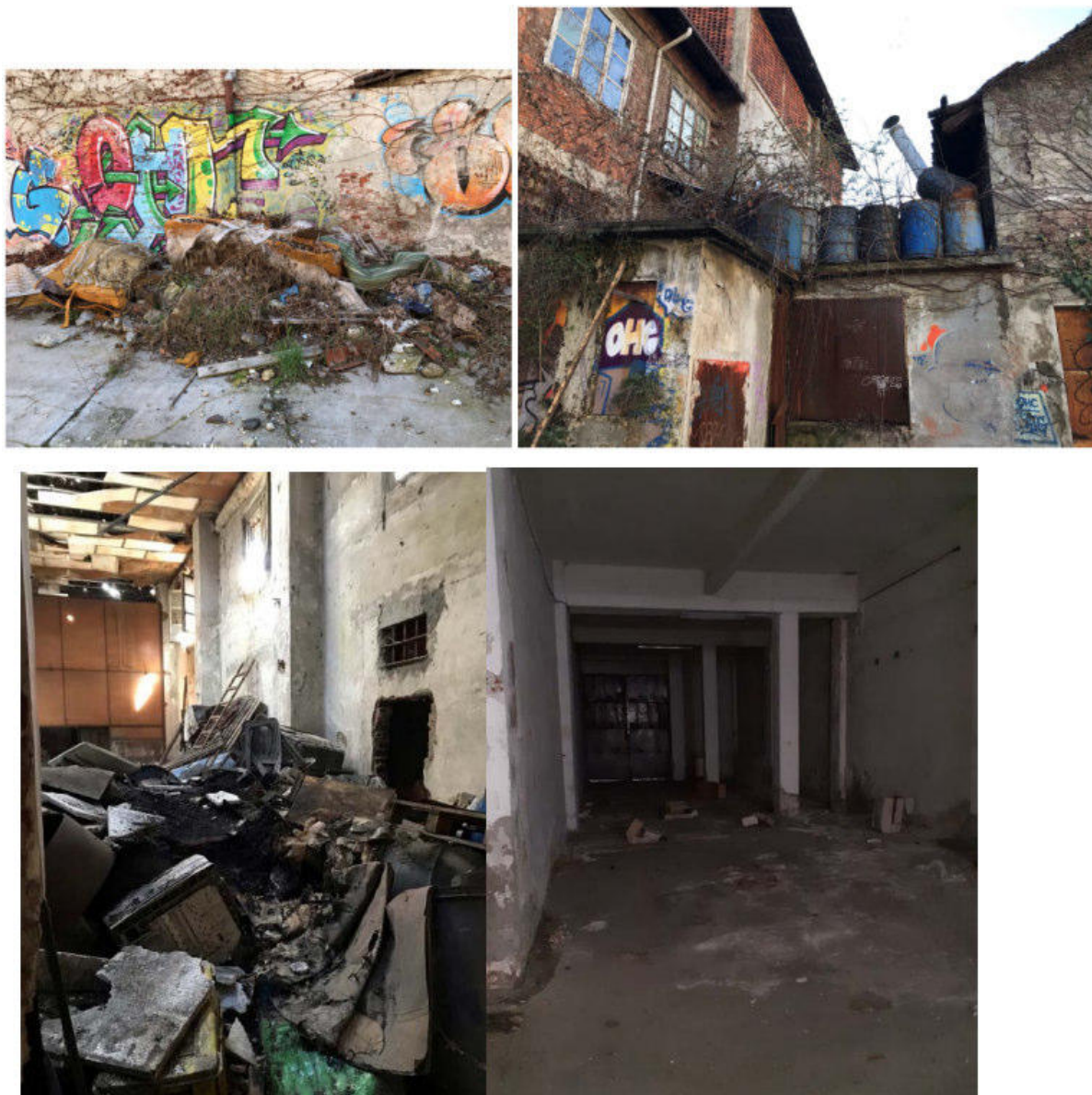
Figura 23: Situazione rifiuti pre-smaltimenti (febbraio 2021)
