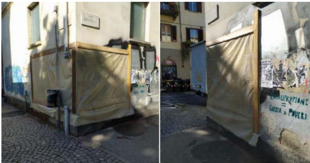
Figura 26: Attività di MISE su incrostazioni Cromo VI
