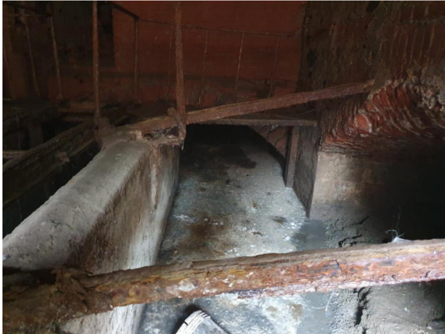
Figura 9 - Saggio esplorativo F2-C2 - Volta Canale Ceronda
