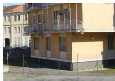
3 - Vista interna dell'area verso palazzina cruciforme
