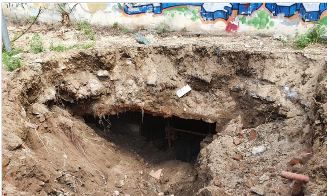
Figura 8 - Saggio esplorativo F2-C2
