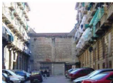
2 - Vista cortile interno Proprietà Grassi (cortile est)
