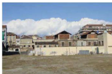
11 – Vista interna all'area
