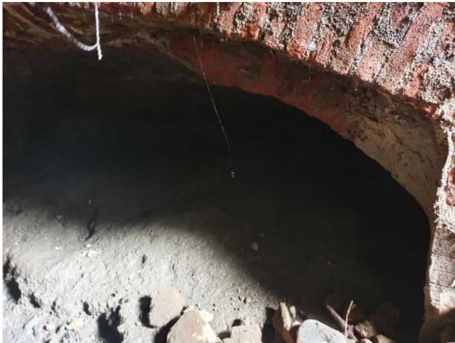
Figura 10 - Saggio esplorativo F2-C2 - Volta Canale Ceronda
