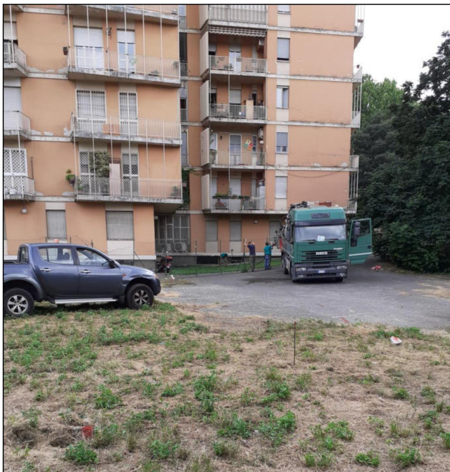
Figura 6 - Operazioni di immissione della tubazione nel nuovo pozzetto di ispezione rinvenuto
