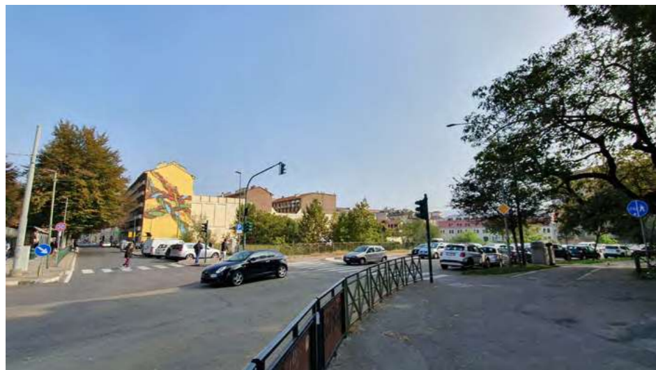
4 - Vista da Ponte Mosca
