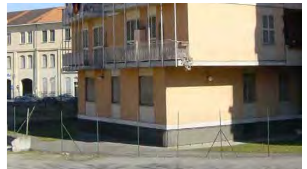
3 - Vista interna all'area verso palazzina cruciforme
