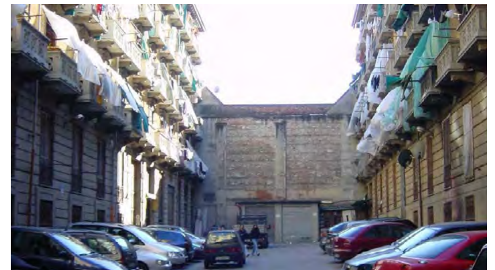
2 - Vista cortile interno Proprietà Grassi (cortile est)
