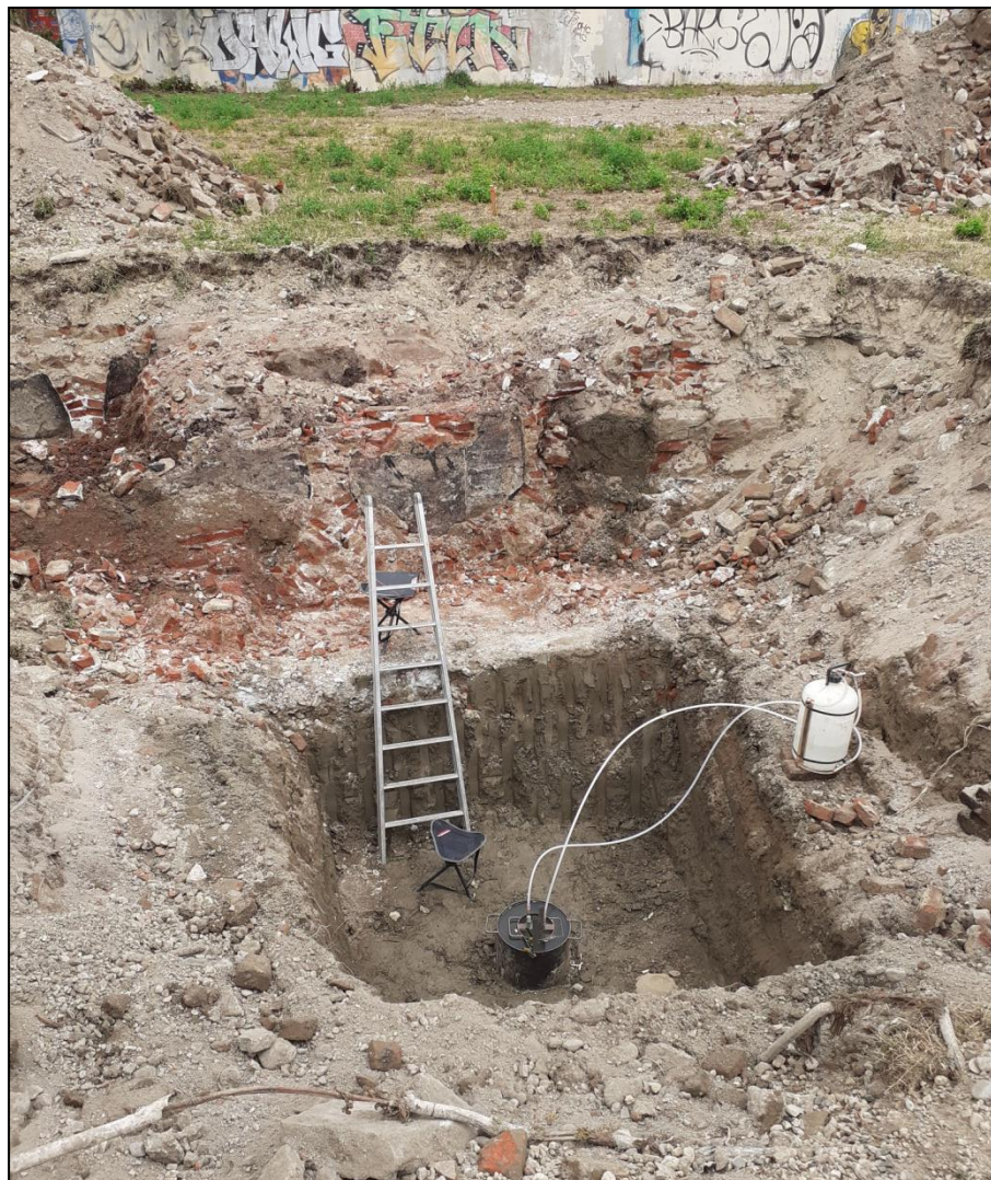
Figura 2 - Scavo per prova infiltrometrica IS2 (prof. 3,60 m da p.c.)
