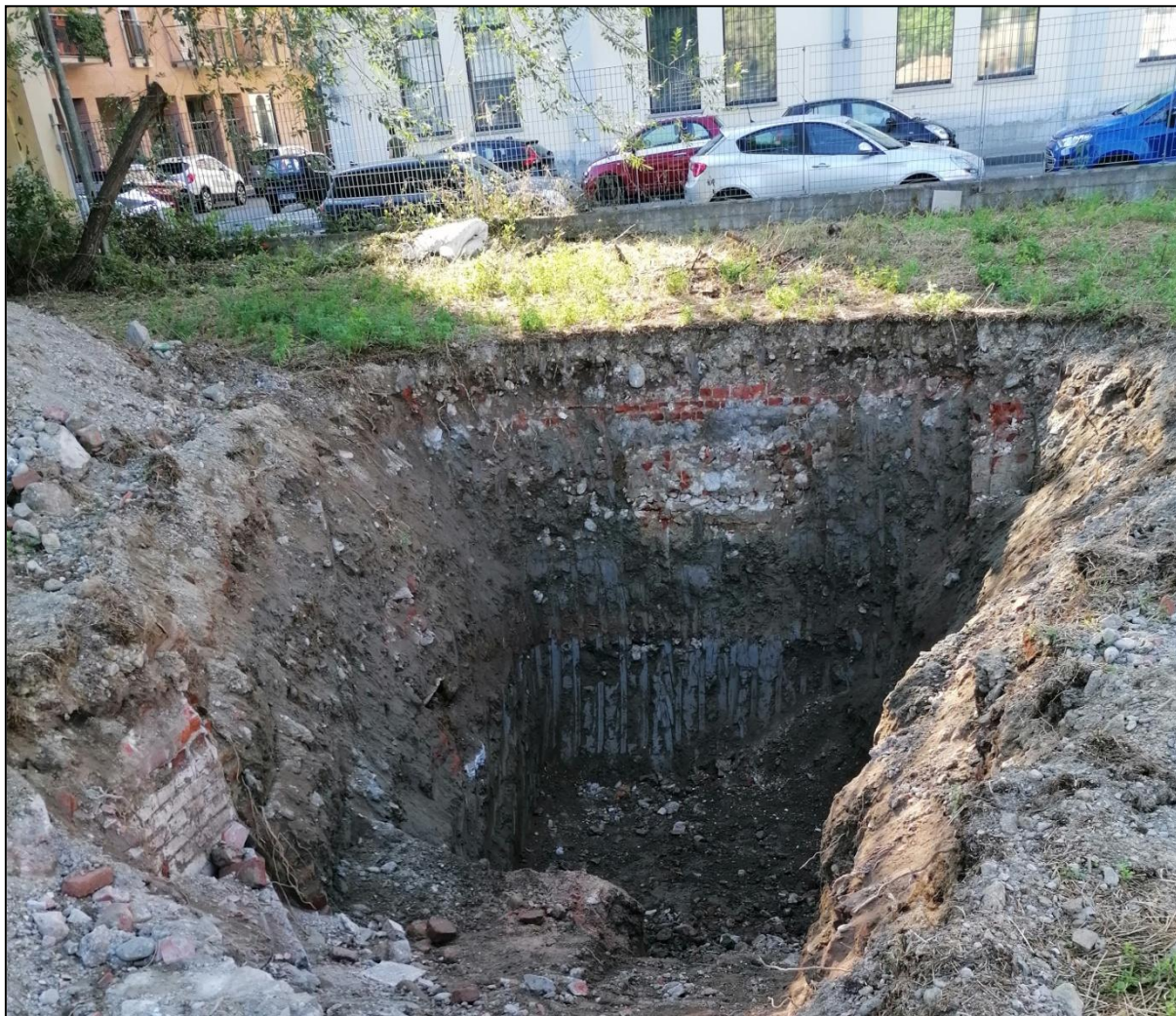
Figura 4 - Scavo per prova infiltrometrica IS4 (prof. 3,40 m da p.c.)
