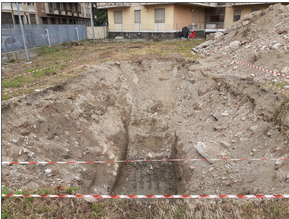
Figura 1 - Scavo per prova infiltrometrica IS1 (prof. 3,70 m da p.c.)
