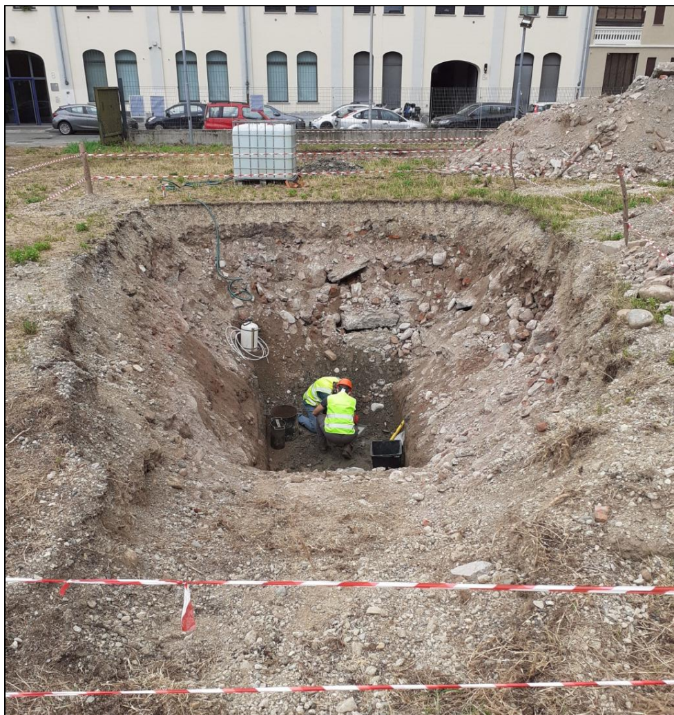
Figura 3 - Scavo per prova infiltrometrica IS3 (prof. 3,50 m da p.c.)
