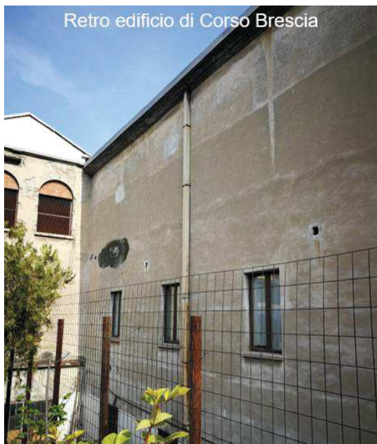
Figura 6 - Particolare tubazioni in cemento amianto
