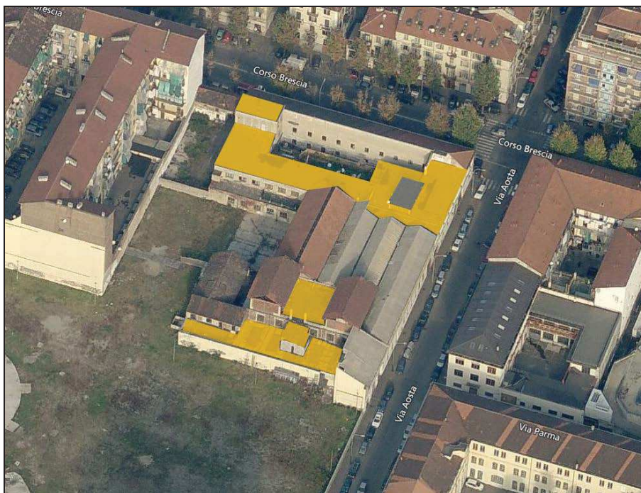
Figura 4 - Indicazione su foto aerea delle coperture in guaina bituminosa con potenziale presenza di amianto (in giallo)
