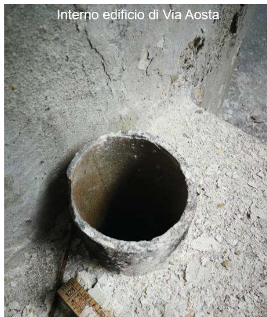
Figura 6 - Particolare tubazioni in cemento amianto
