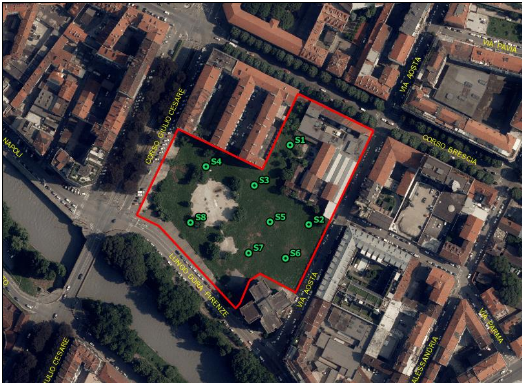
Figura 3.1 – Foto aerea con ubicazione dei sondaggi geognostici
