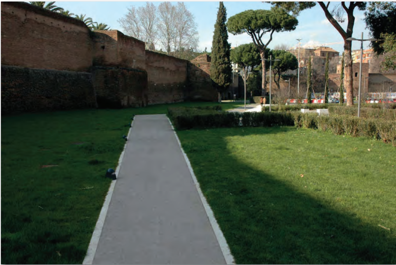
Pavimentazione in terra stabilizzata
