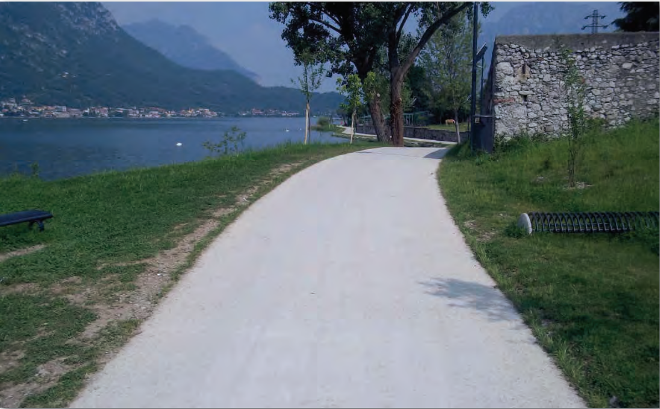
Pavimentazione in terra stabilizzata
