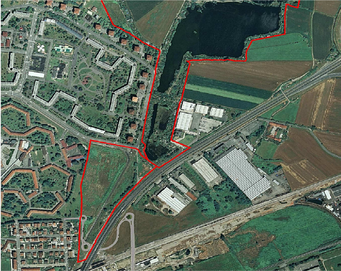
Vista aerea con identificazione in color rosso della ZUT2.6 Laghetti Falchera e del Parco P25
