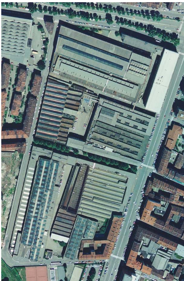
Figura 17 – Fotografia aerea dell'area di intervento prima delle demolizioni
