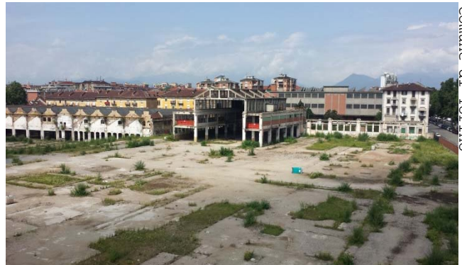
Figura 20 - Vista della Basilica dall'interno dell'area
