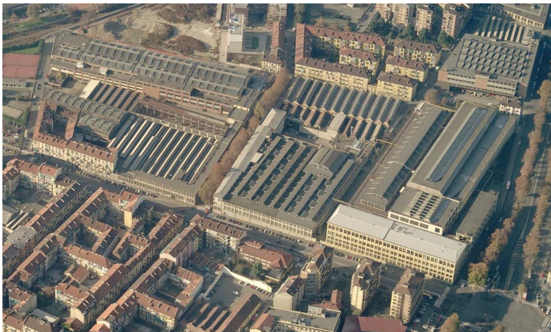
Figura 16 – Vista a volo d'uccello prima delle demolizioni
