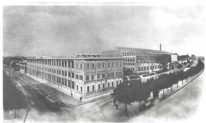
Figura 2 - Vista dello stabilimento da Corso Vigevano.
