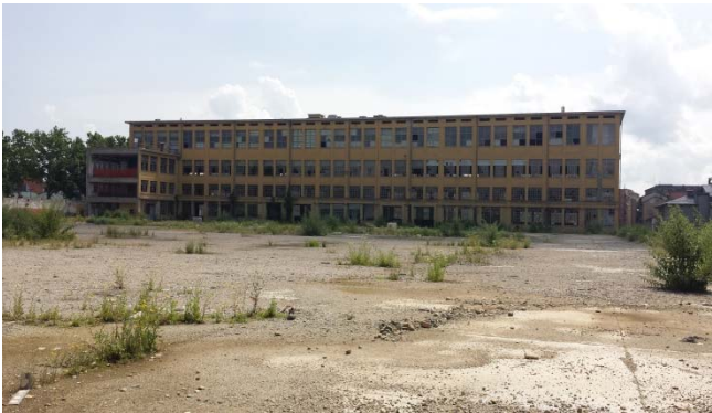
Figura 19 - Vista Lingottino dall'interno dell'area
