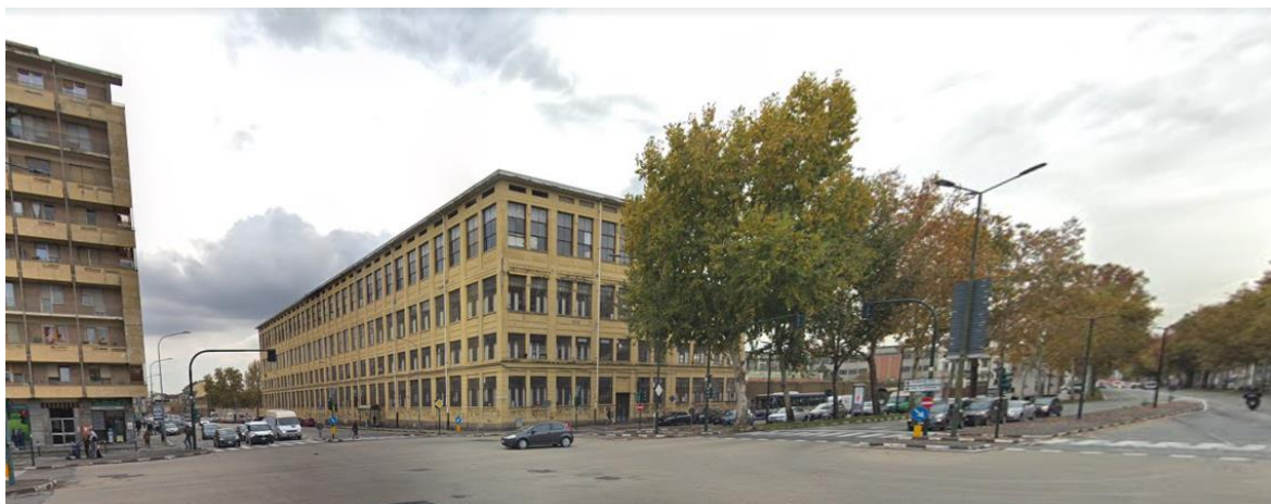
L'edificio del "Lingottino" localizzato all'angolo tra Corso Vigevano e Corso Vercelli, visto da Piazza Crispi
