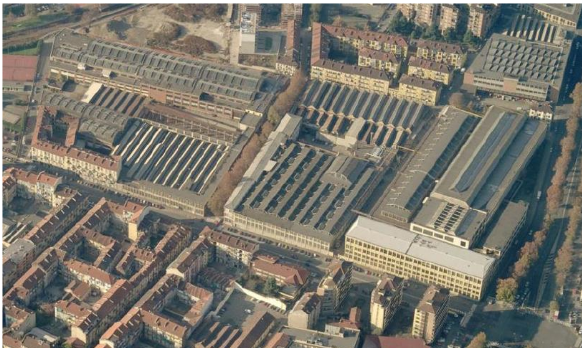
Vista dell'area di progetto nello stato precedente le demolizioni di una parte dei fabbricati
