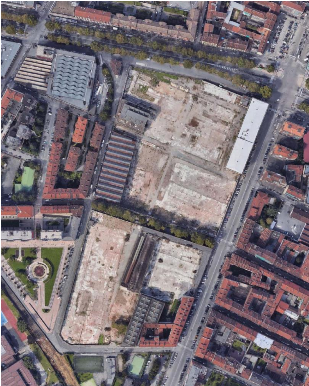
Foto aerea dell'area del PRIN nella situazione attuale
