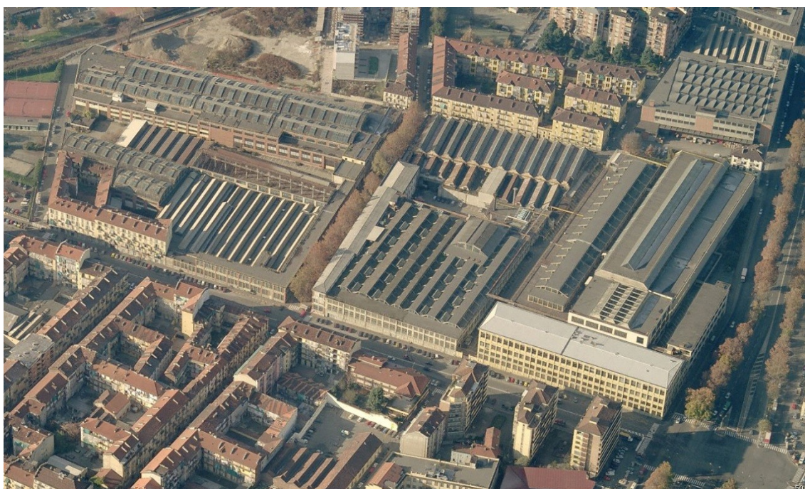
FIGURA 3 - VISTA PRIMA DELLE DEMOLIZIONI
