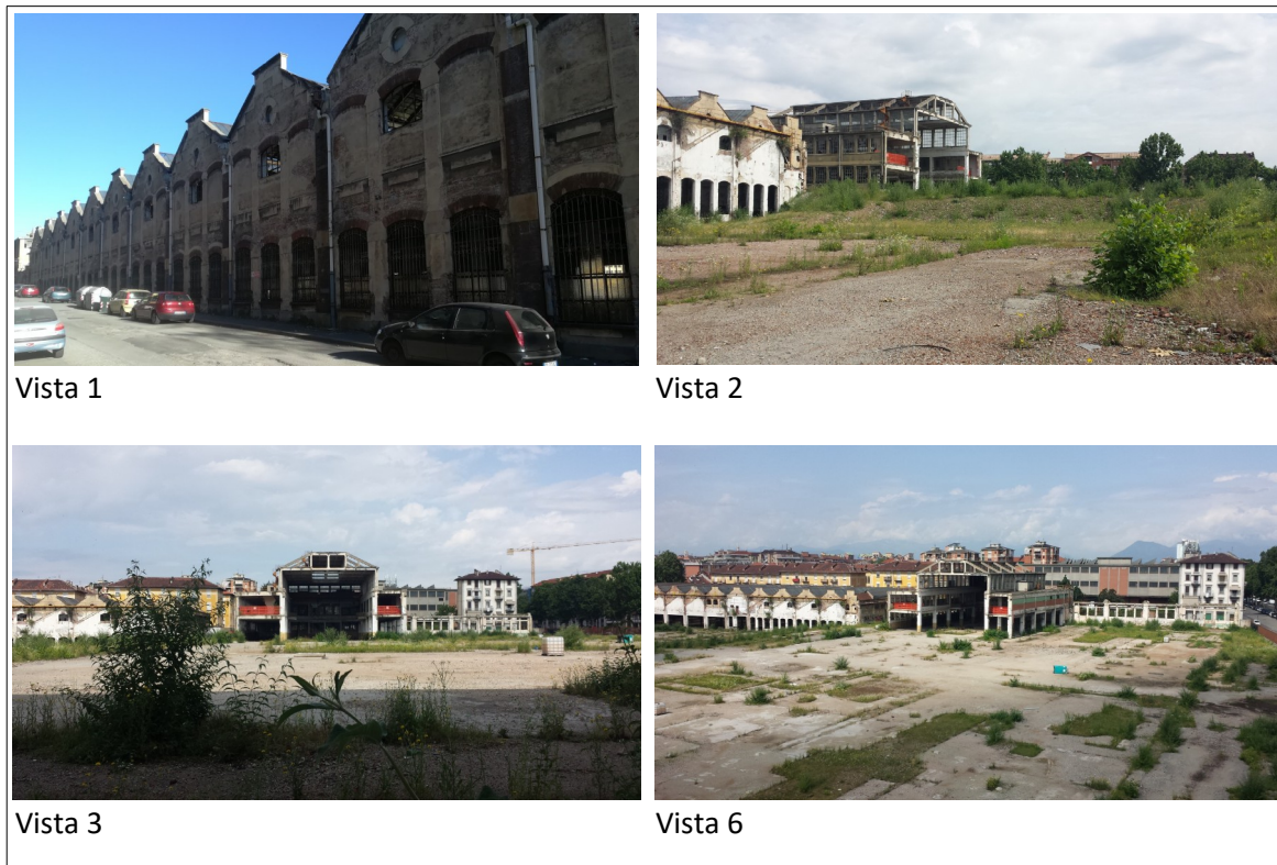
FIGURA 7: VISTE AREA NORD DELL'AMBITO, "EDIFICIO FENOGLIO" E "BASILICA"
