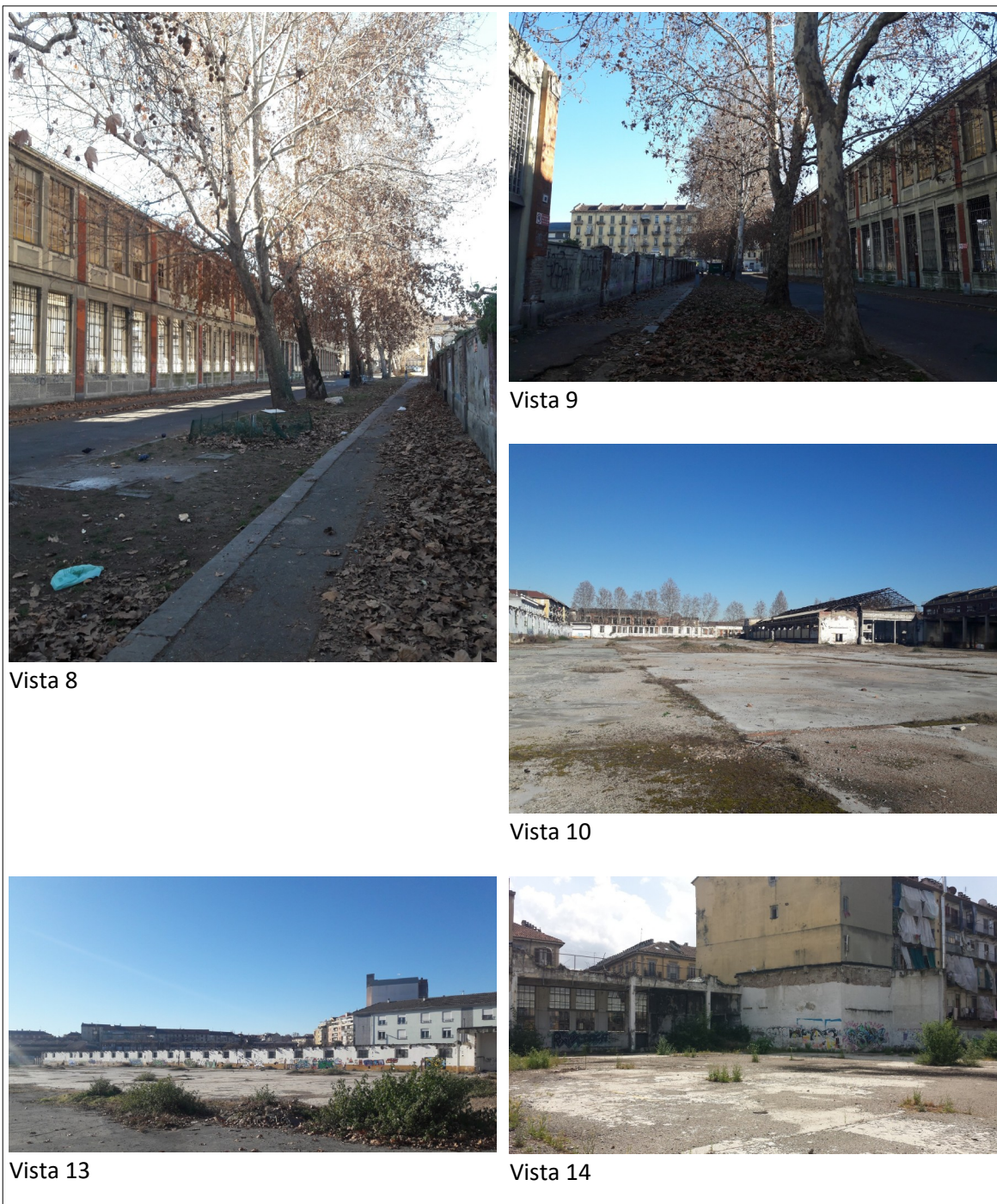
FIGURA 8: VISTE MURI DI DELIMITAZIONE, LUNGO LE VIE DAMIANO E CUNEO
