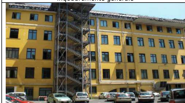
Prospetto interno cortile della manica
