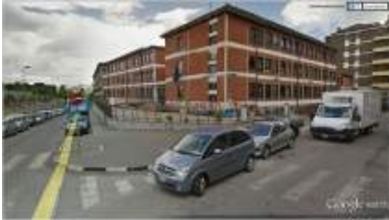
Prospetto istituto Lagrange e Lessona
