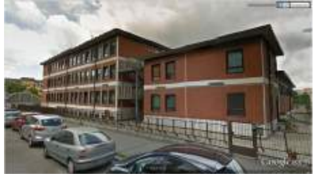
Prospetto istituto Lagrange e Lessona
