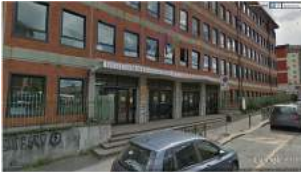
Prospetto istituto Lagrange e Lessona
