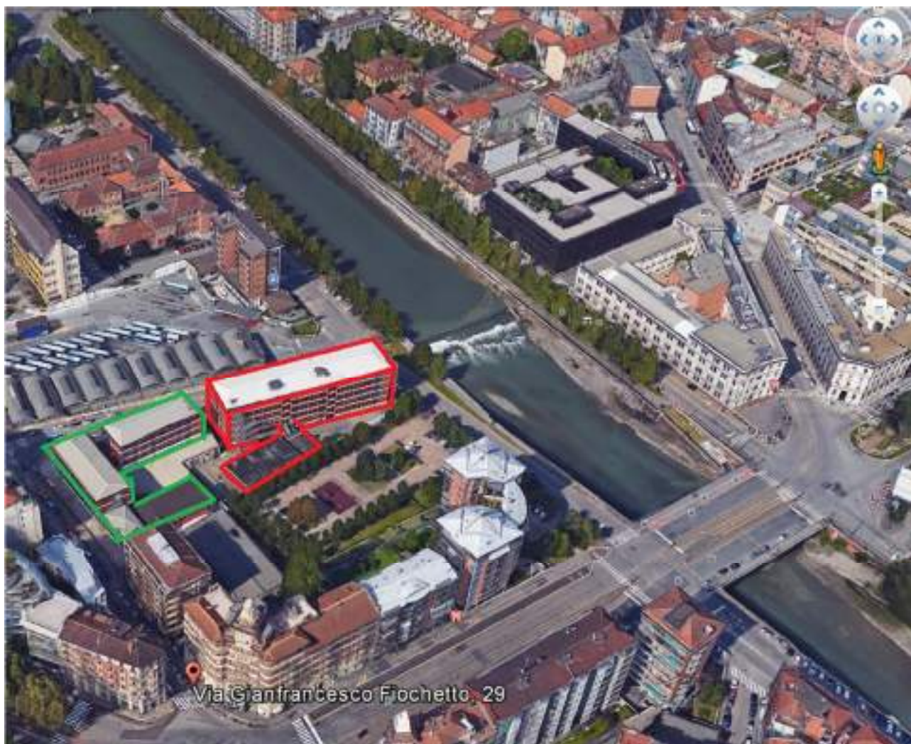
Inquadramento aerofotogrammetrico dell'edificio oggetto di analisi: in verde La scuola elementare Lessona, in rosso l'Istituto Superiore Lagrange
