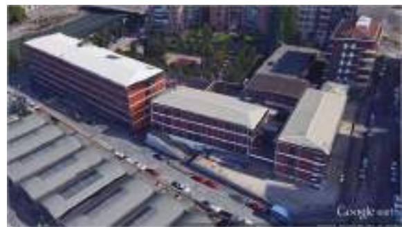
Prospetto istituto Lagrange e Lessona
