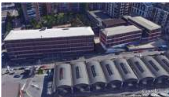
Prospetto istituto Lagrange e Lessona
