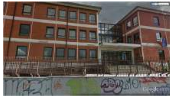
Prospetto istituto Lagrange e Lessona
