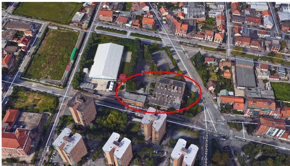
Inquadramento aerofotogrammetrico dell'edificio oggetto di analisi
