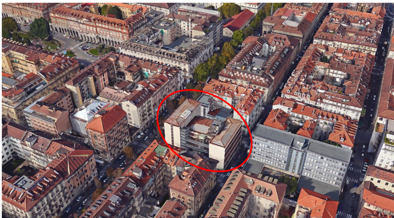
Inquadramento aerofotogrammetrico dell'edificio oggetto di analisi
