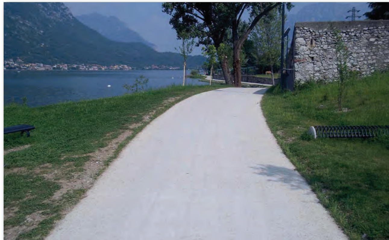
Pavimentazione in terra stabilizzata
