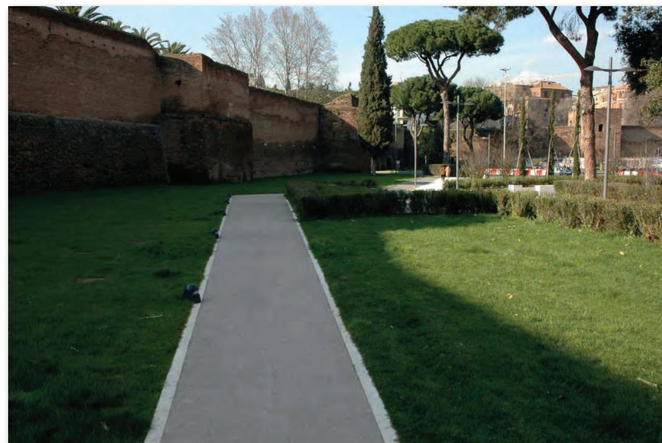
Pavimentazione in terra stabilizzata
