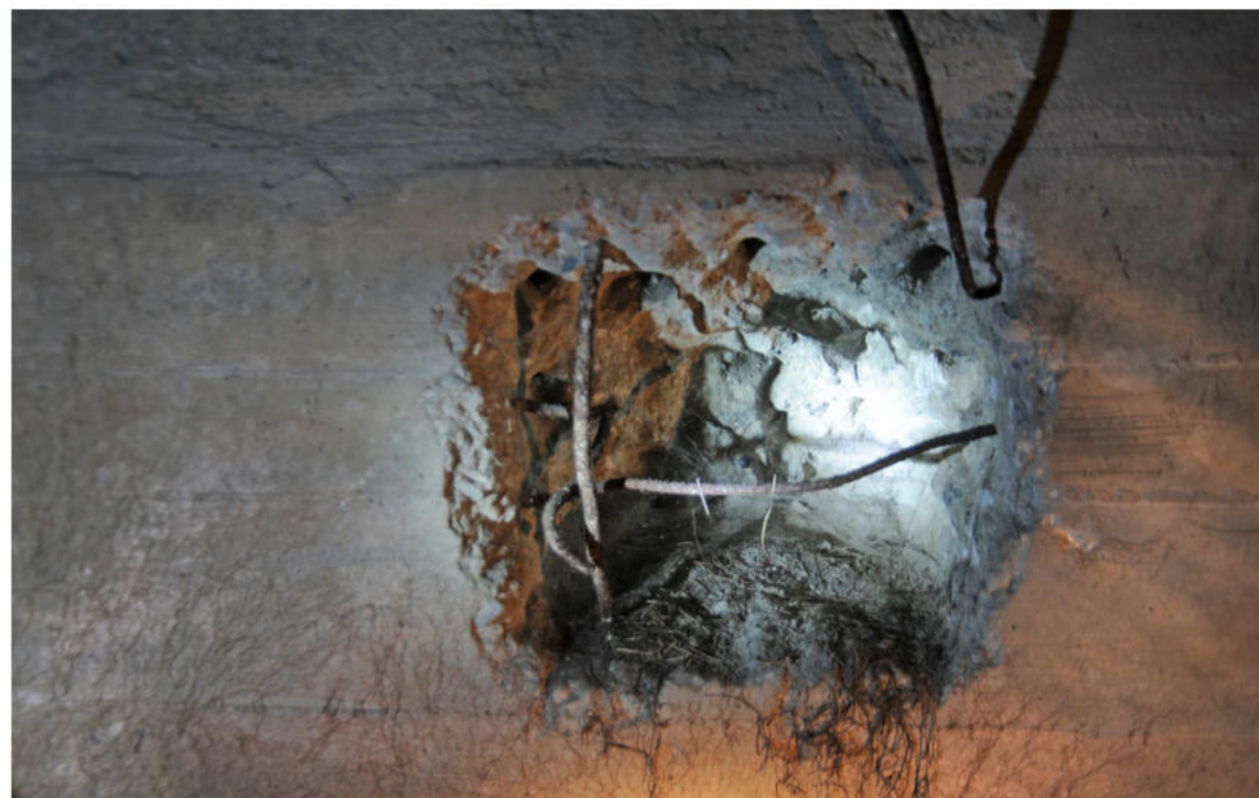
14_ galleria ovest, saggio sulla struttura in calcestruzzo armato
