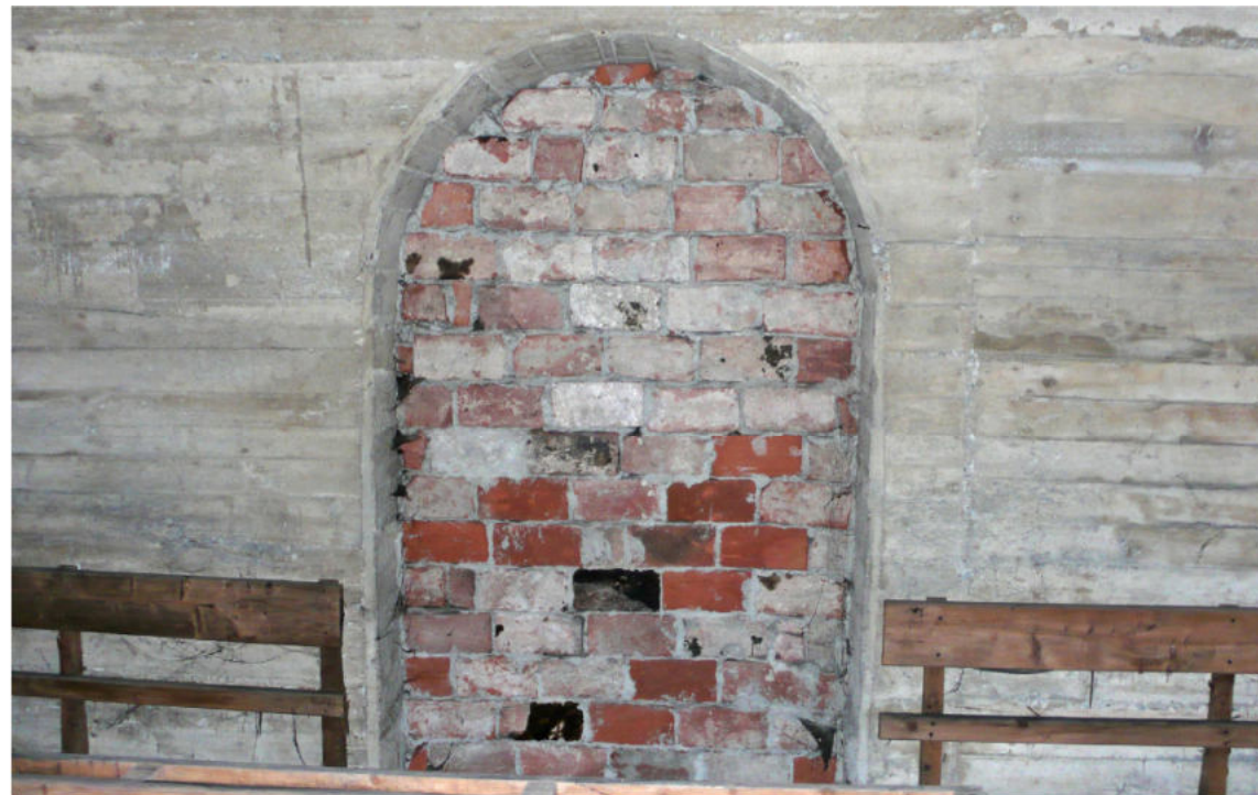
13_ galleria ovest, nicchia murata
