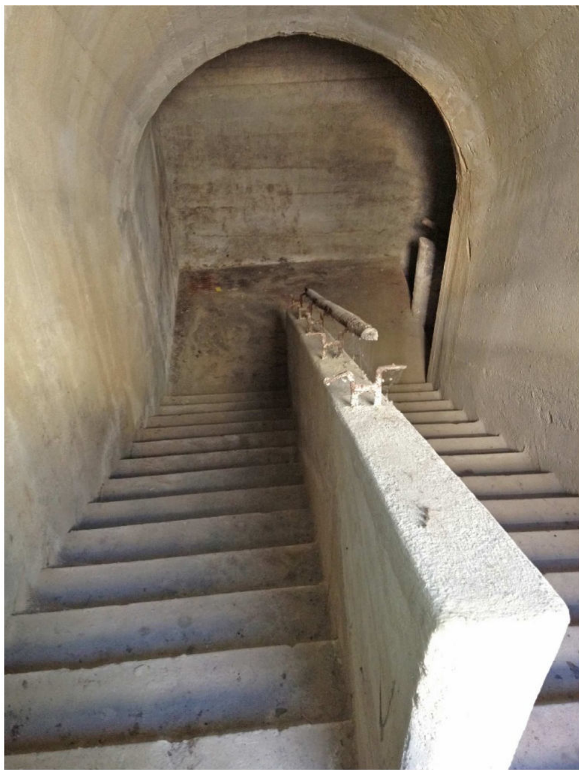
1_scala d'ingresso al rifugio_prima rampa
