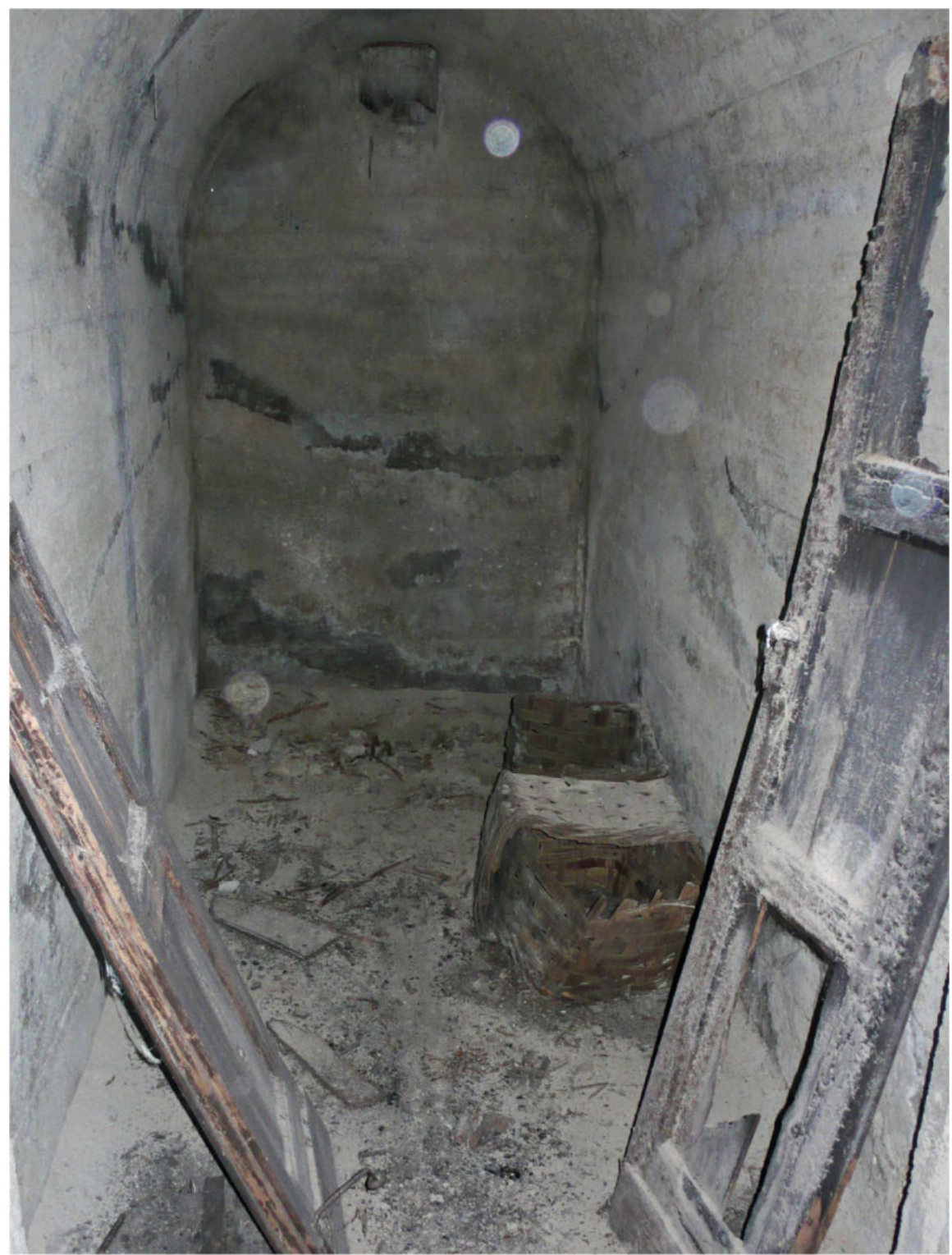
3_locale accessorio a lato della scala d'ingresso
