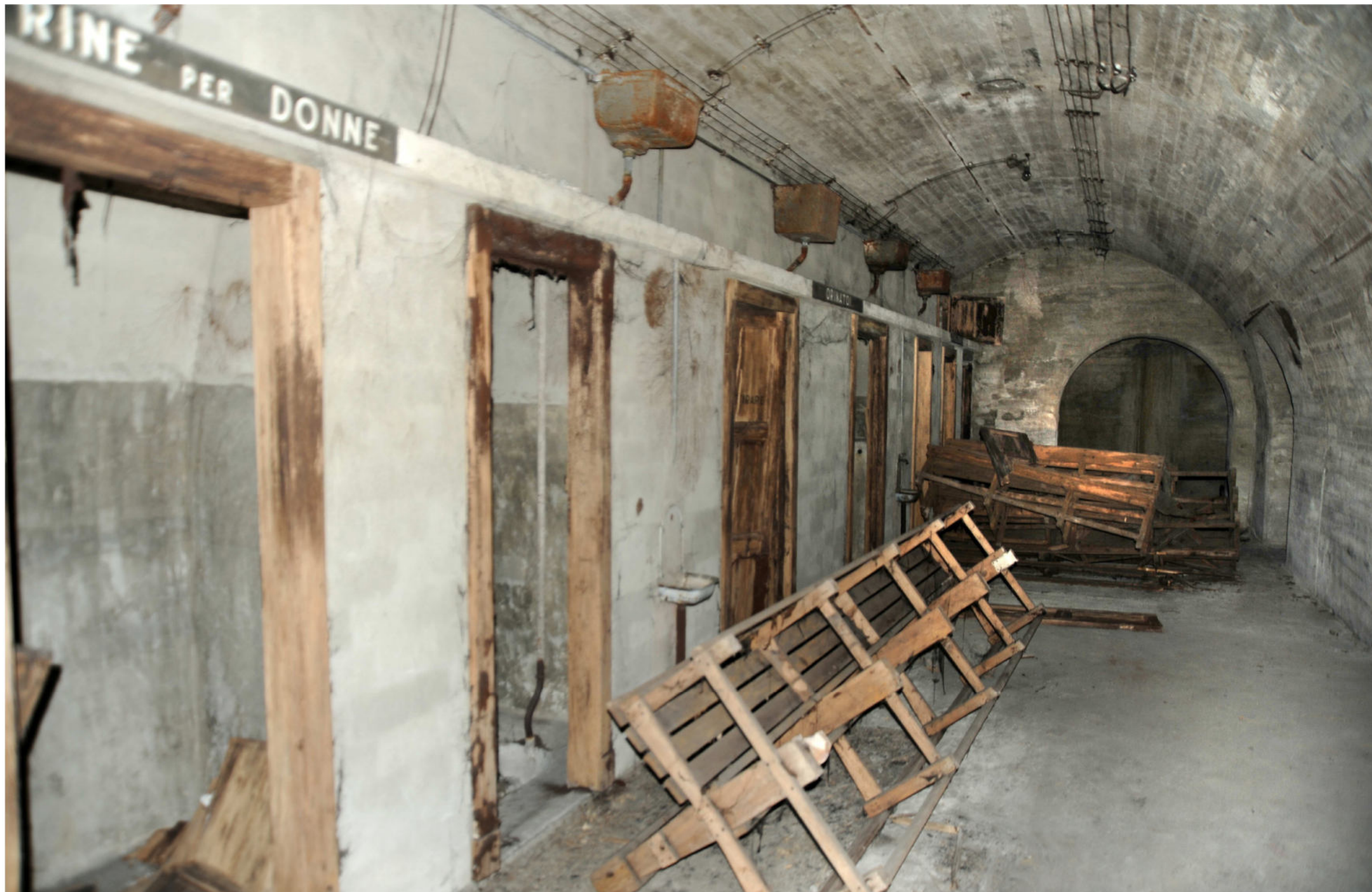
5_galleria trasversale ospitante le latrine e gli orinatoi
