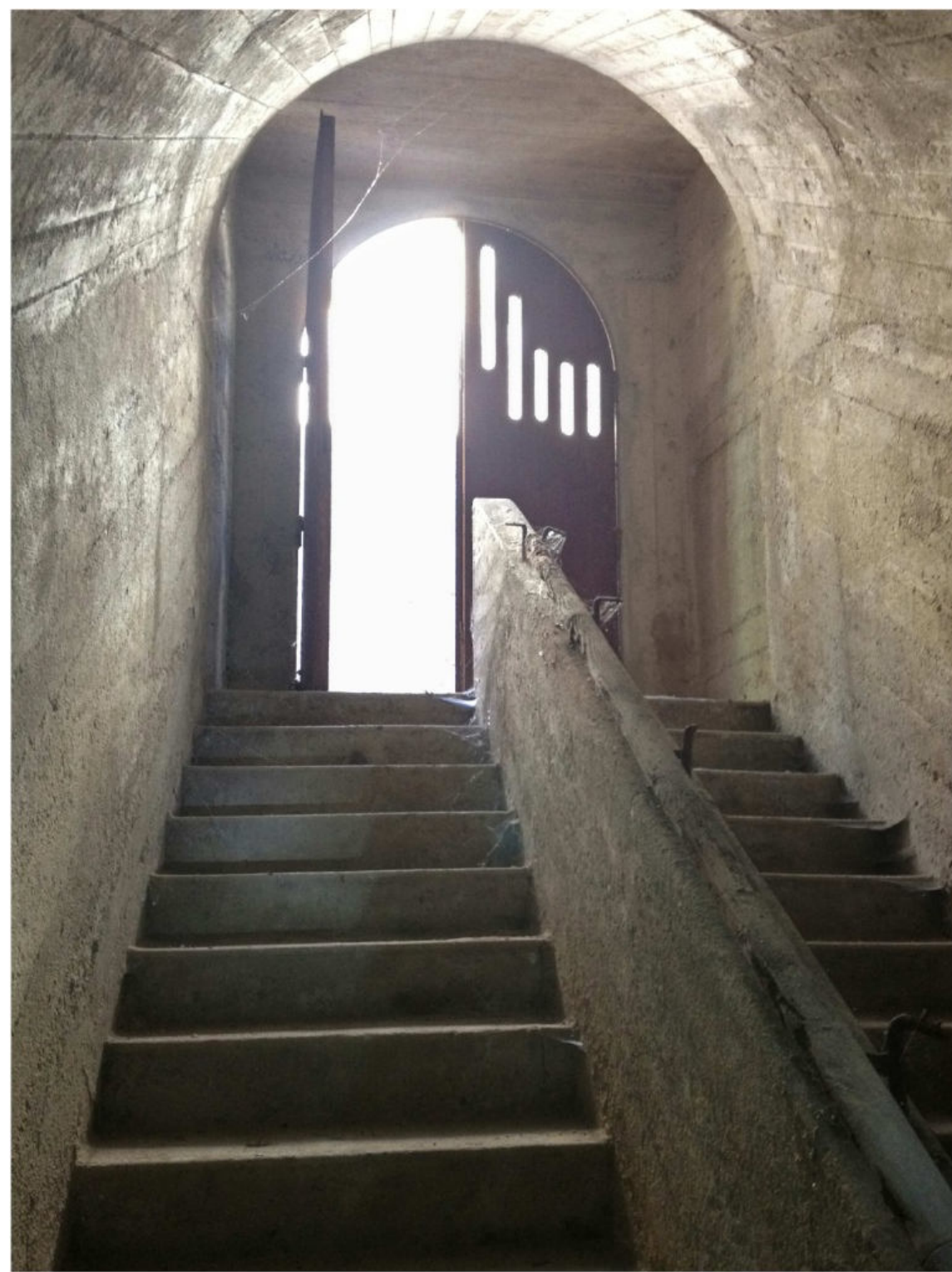
2_scala d'ingresso al rifugio_vista del portone d'accesso
