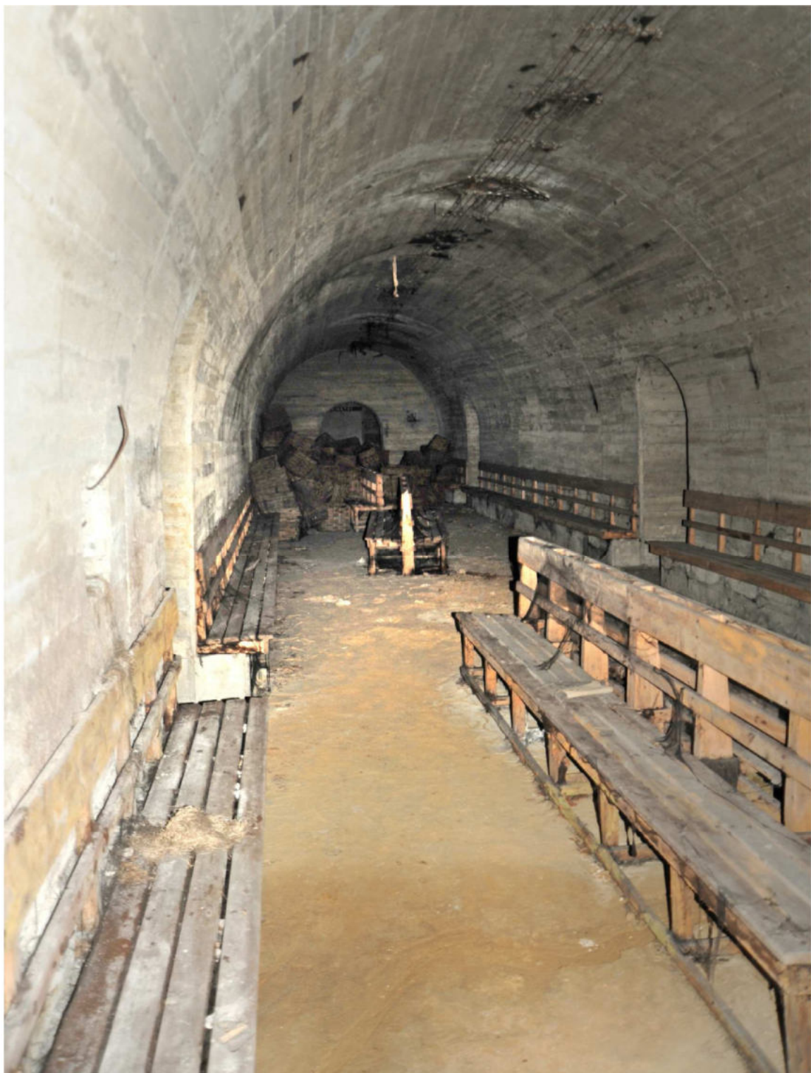
20_ galleria centrale_primo tratto
