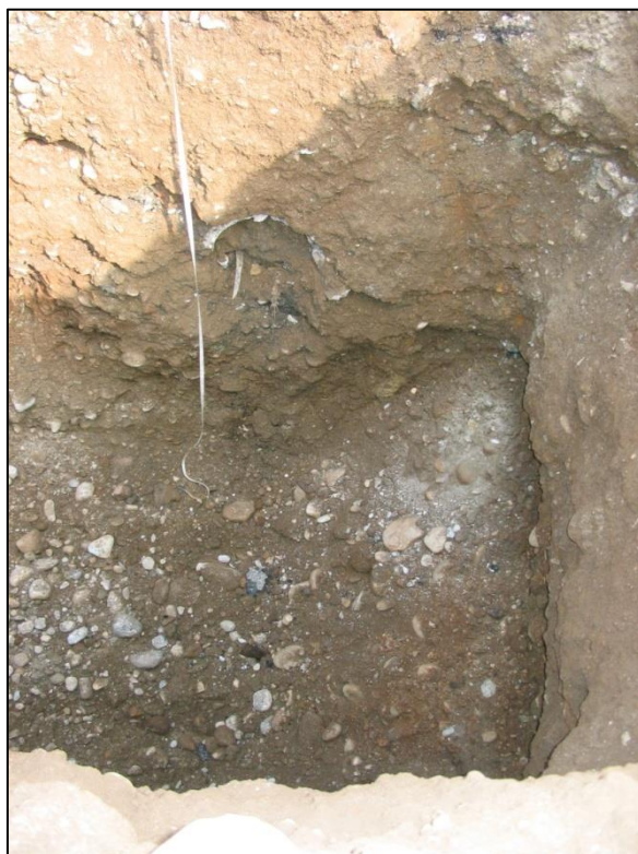
Pozzetto esplorativo P12. Angolo Nord-Est e Lato Est.
