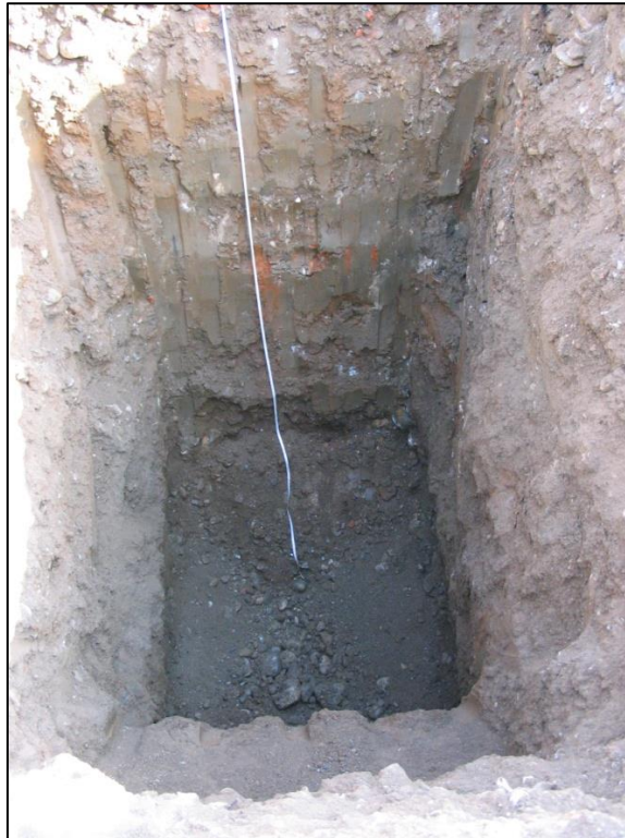
Pozzetto esplorativo P1.
