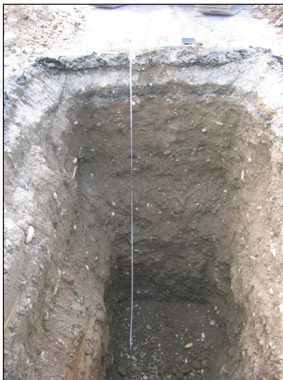
Pozzetto esplorativo P8. Lato Sud.
