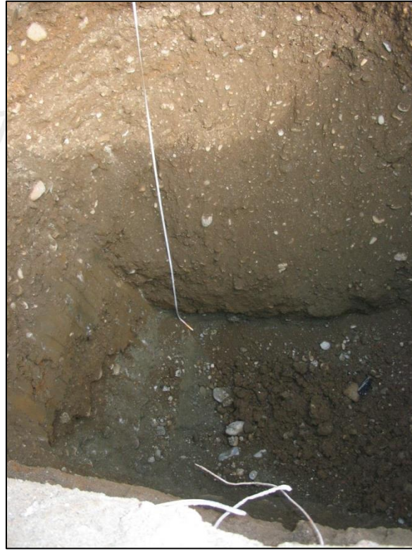
Pozzetto esplorativo P11. Lato Nord.
