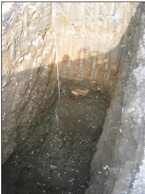
Pozzetto esplorativo P8. Lato Nord.
