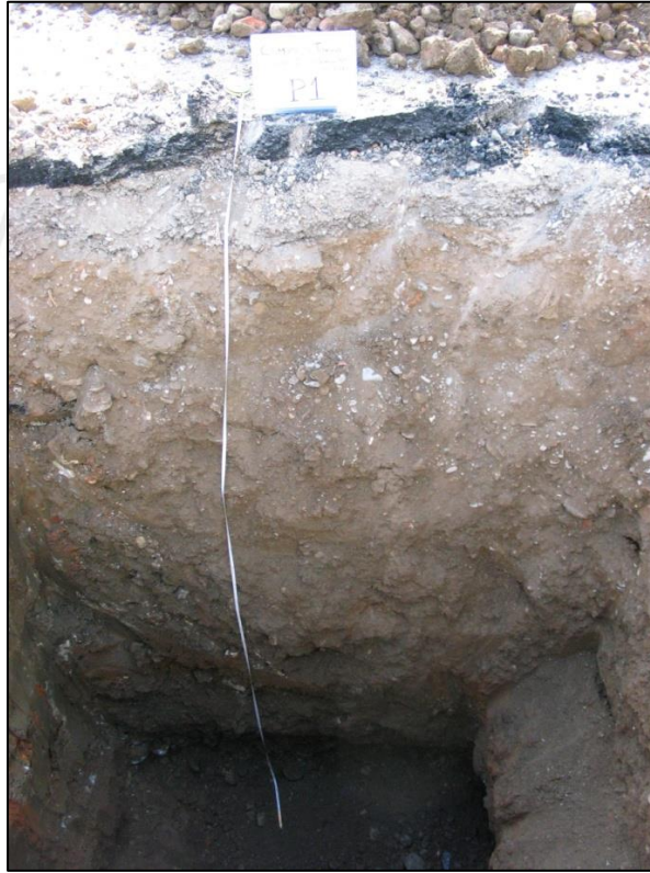
Pozzetto esplorativo P1.
