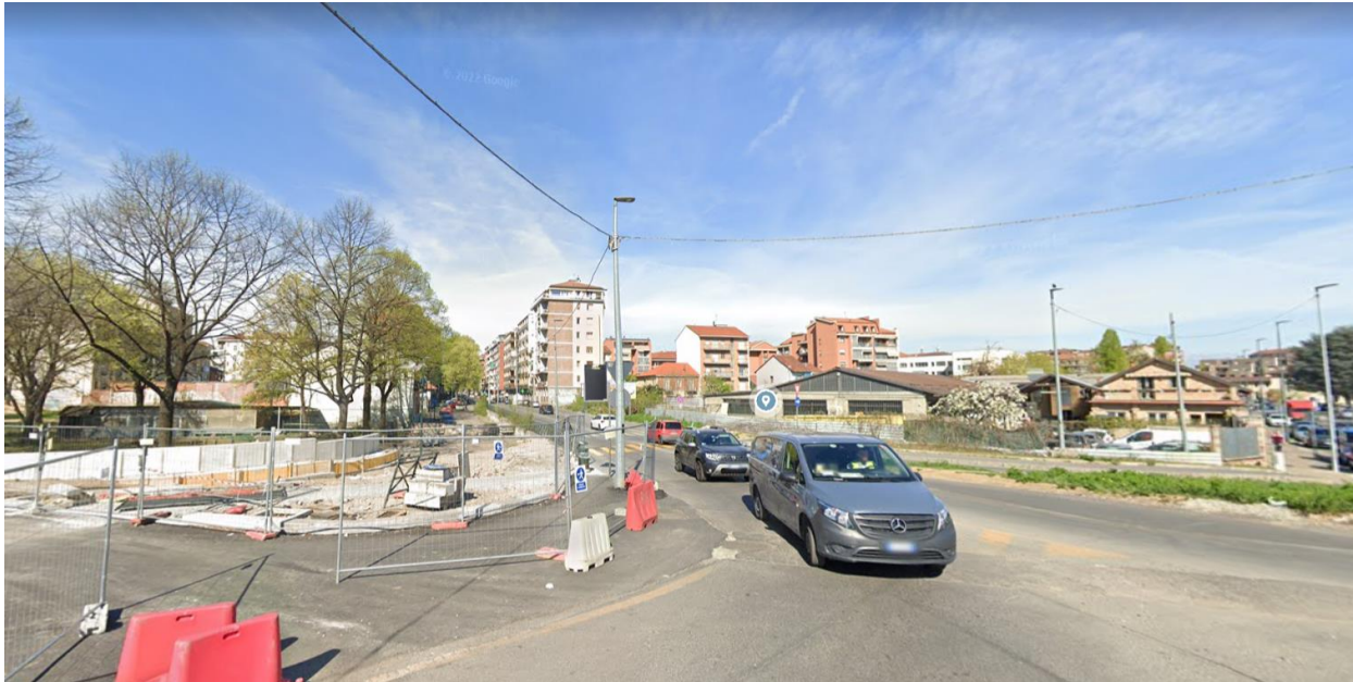
Figura 11 – Vista da rotonda corso Venezia verso isolato compreso tra via Breglio e via Ala di Stura
