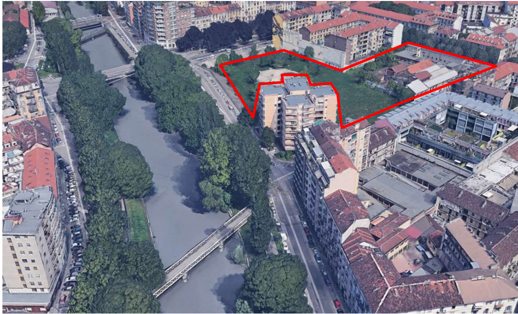
Figura 2.2: Localizzazione dell'area di intervento - veduta da Sud-Est
