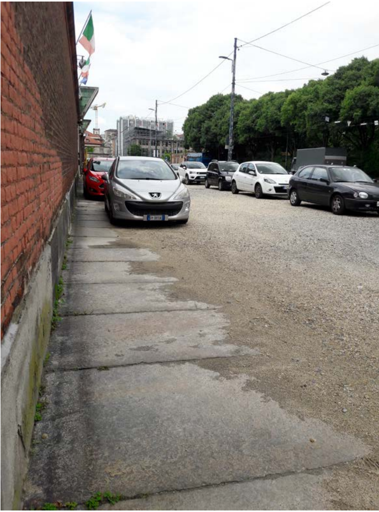
Lotto 7: Il marciapiede in pietra esistente e l'attuale area a parcheggio antistante le ex Carceri
