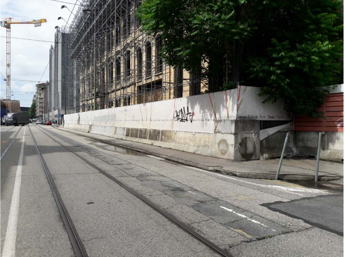
Lotto 7: L'attuale sede stradale e marciapiede antistante Le Ex officine Nebiolo
