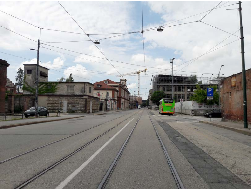
Lotto 7: La sede stradale di via Borsellino in corrispondenza della futura intersezione con la nuova viabilità di servizio
