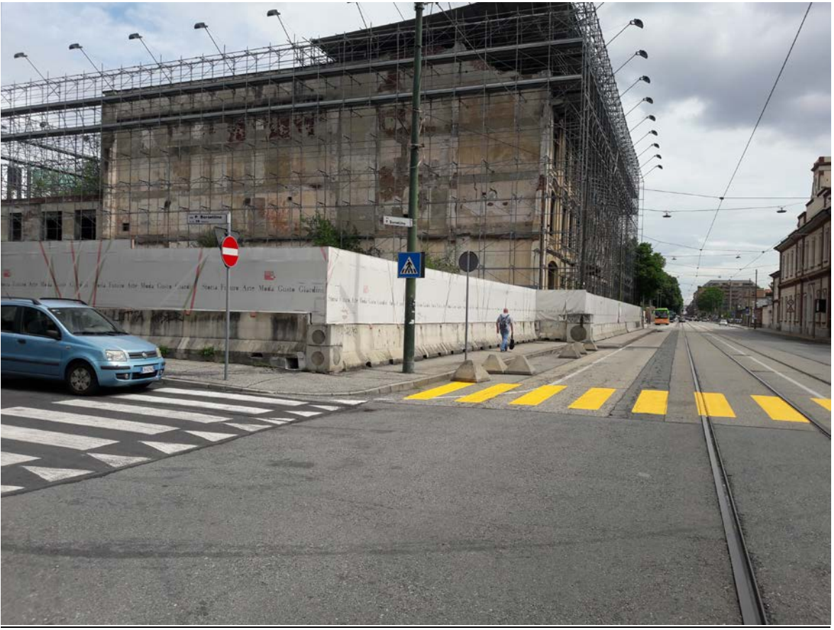
Lotto 7: La banchina ovest di via Borsellino all'incrocio via Borsellino – via Borsellino int. 38, ove il marciapiede verrà allargato.
