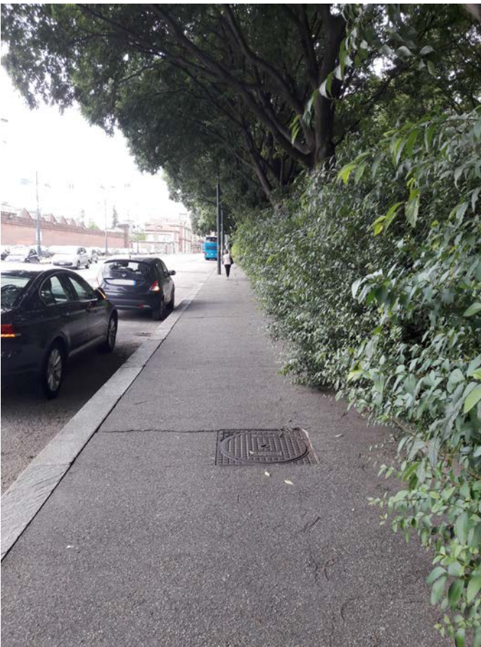
Lotto 11: marciapiede via Borsellino (lato ovest)
