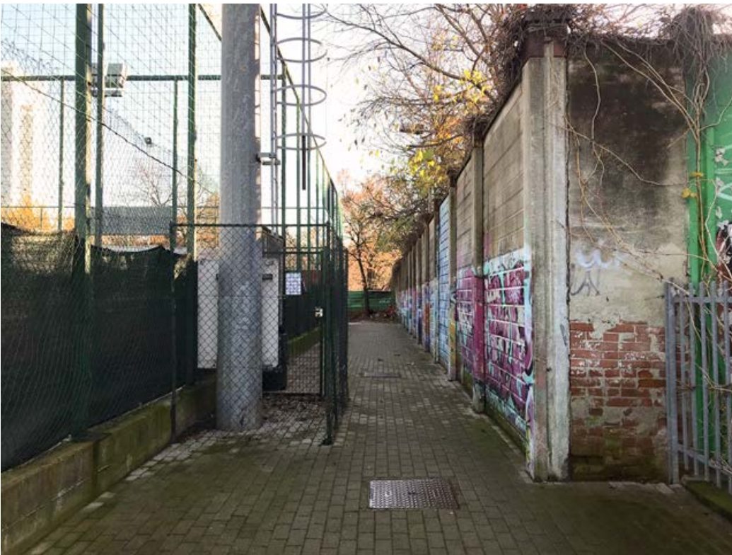
Lotto 9: vista dell'attuale percorso pedonale di collegamento tra il viale Cit Turin e corso Ferrucci. Il muro a destra verrà demolito, liberando le alberature esistenti e realizzando posteriormente una nuova recinzione metallica.
