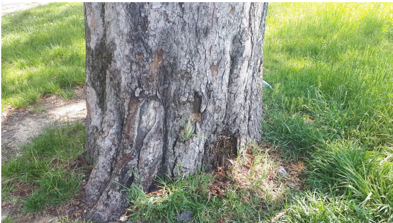
Figura 7 - Dettaglio della carie evidente alla base del soggetto arboreo n°92. In evidenza la diffusa presenza di Carpofori.
