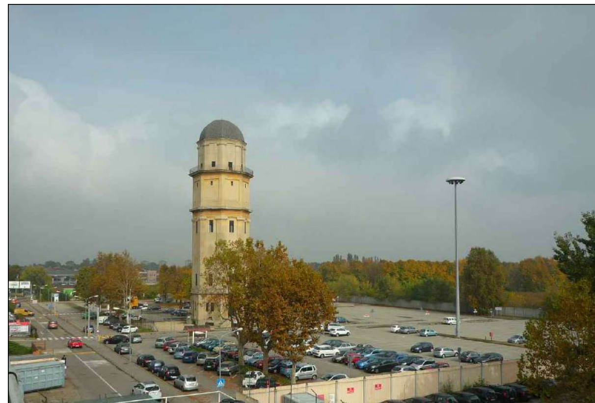
AMBITO 2.8/2 | TORRE PIEZOMETRICA
