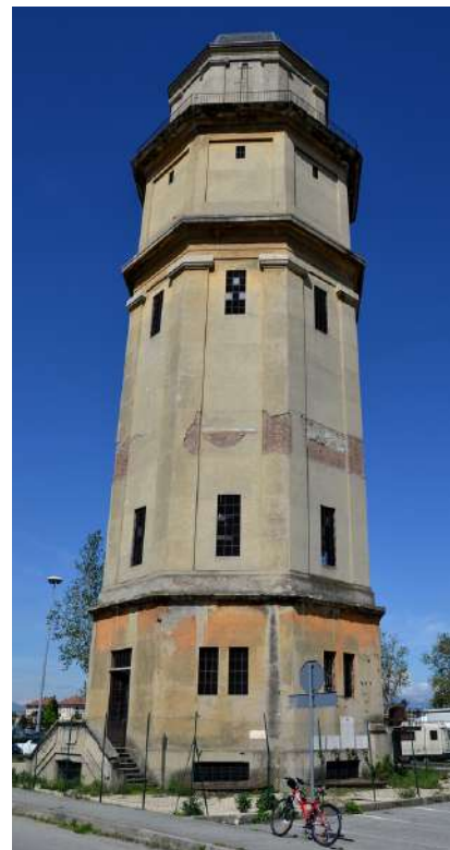
Figura 1 La Torre Piezometrica oggi
