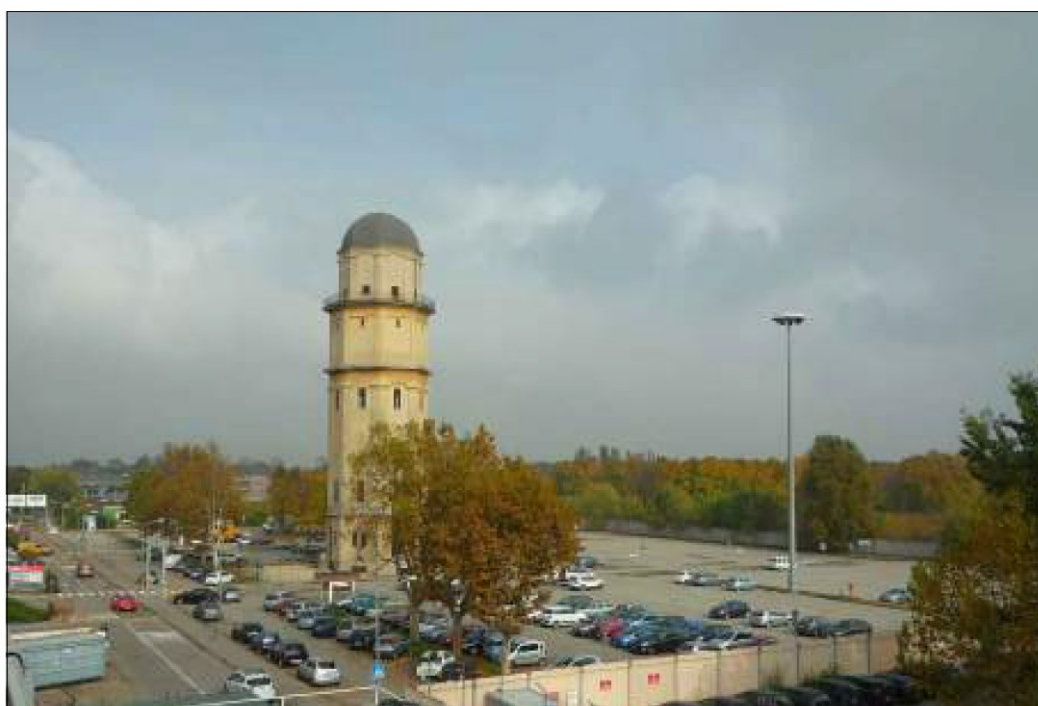
Figura 7: Ripresa fotografica torre piezometrica
