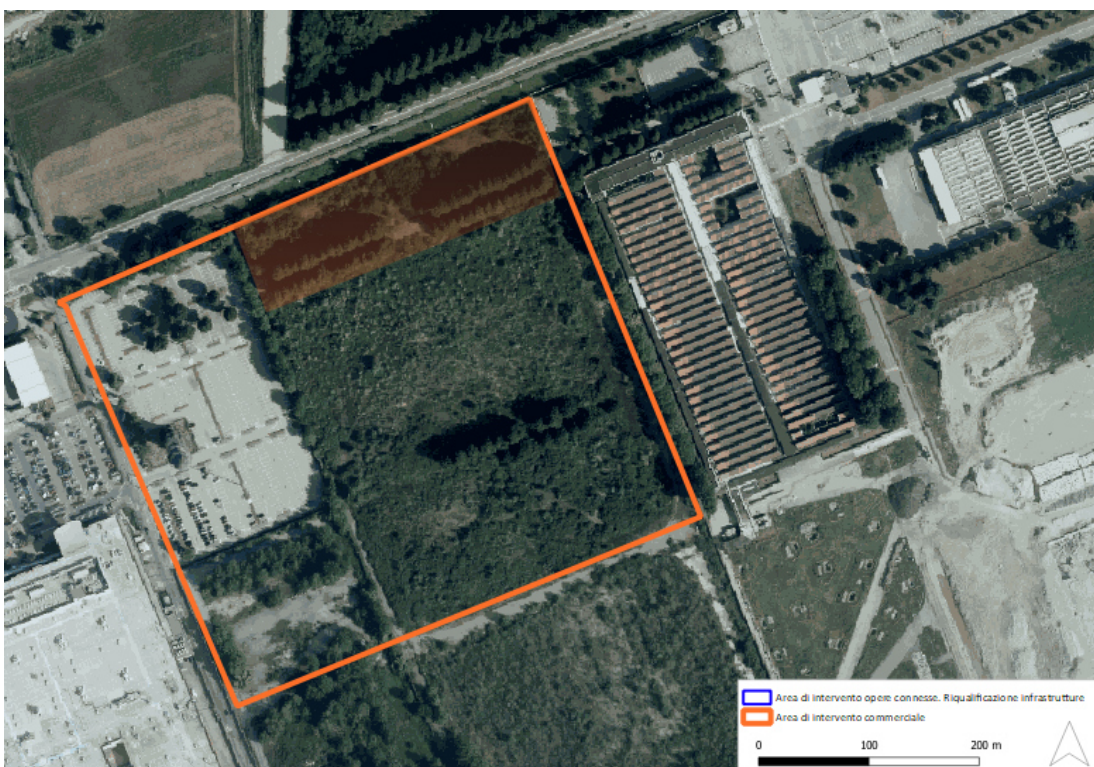
Figura 8: Individuazione porzione in fregio a Corso Romania descritta su lotto oggetto di PEC
