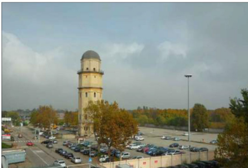
Figura 15: Ripresa fotografica torre piezometrica
