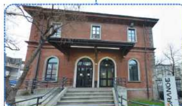
EDIFICIO VINCOLATO VIA NIZZA - PALESTRA ORANGE
