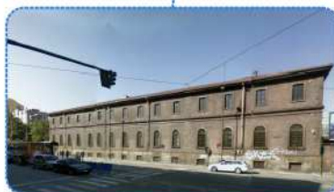
EDIFICIO VINCOLATO VIA NIZZA - PALESTRA ORANGE
