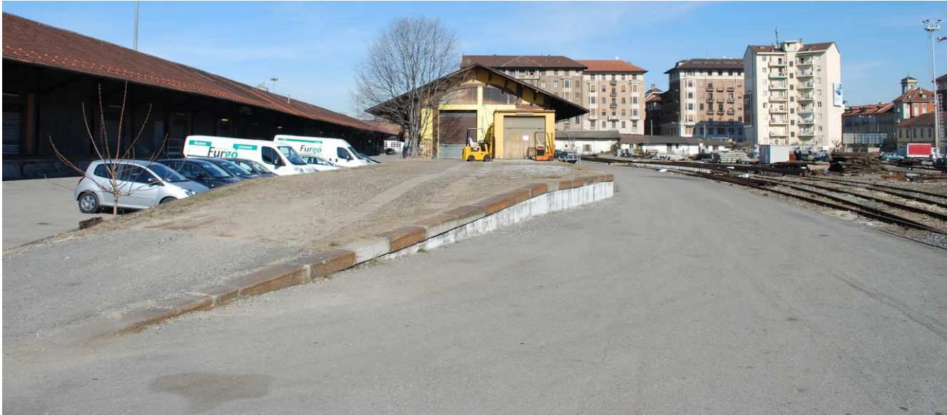
Foto 5 - Rampa di risalita al magazzino a fianco dei binari
