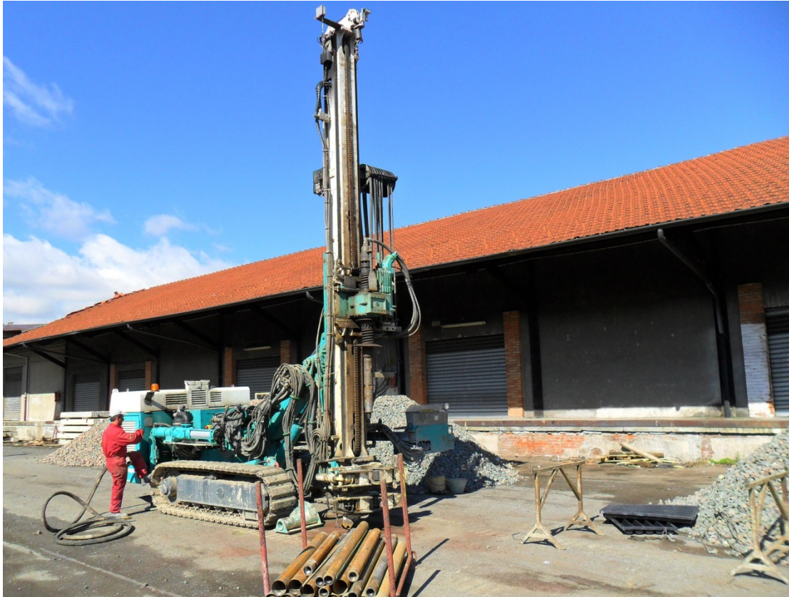
Sonda perforatrice Casagrande C6. Postazione S.5
