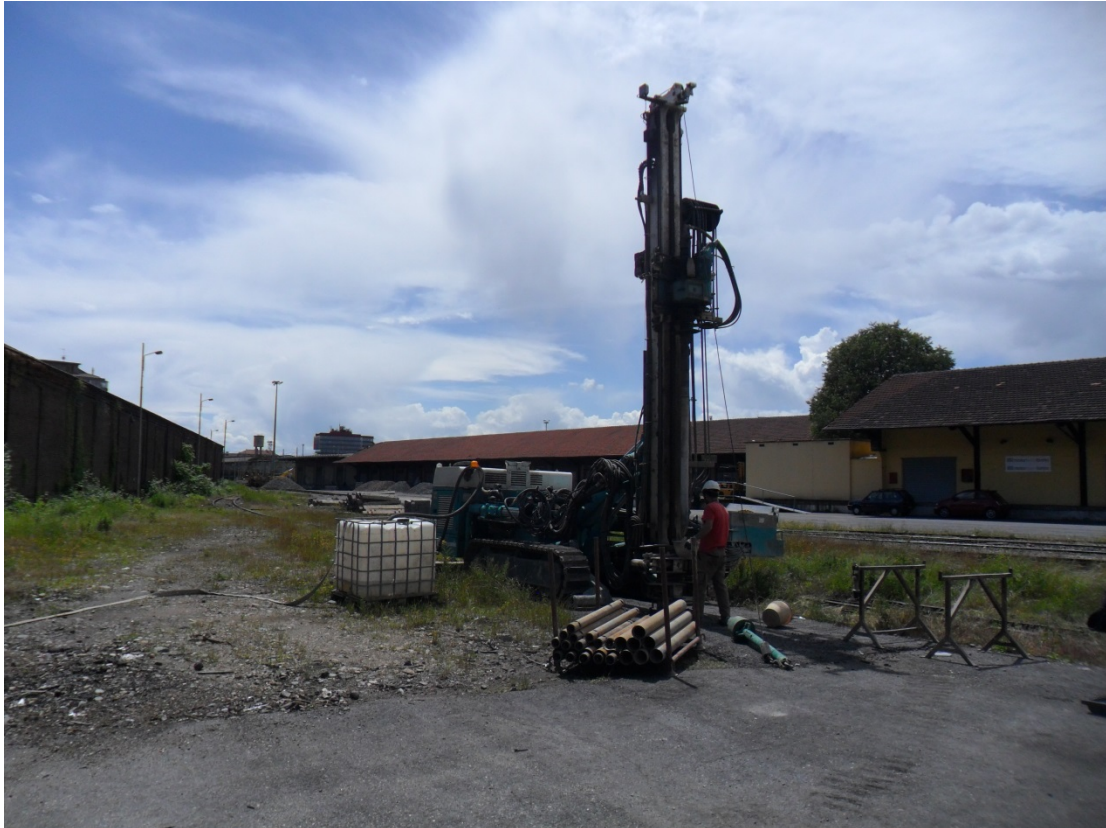
Sonda perforatrice Casagrande C6. Postazione S.3
