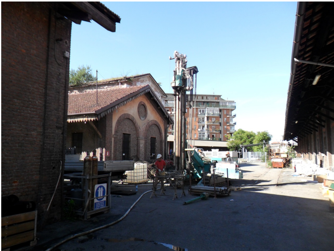
Sonda perforatrice Casagrande C6. Postazione S.2
