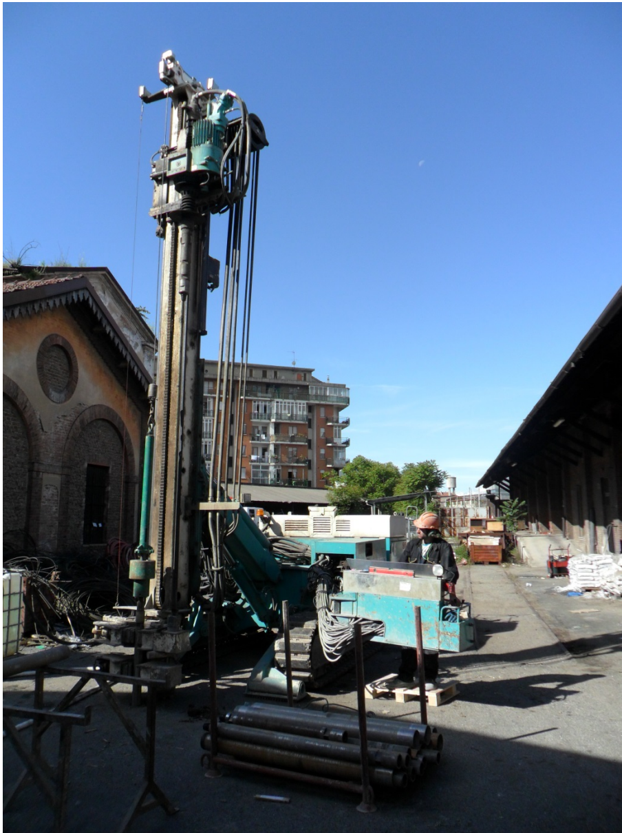
Esecuzione prove S.P.T. Postazione S.2
