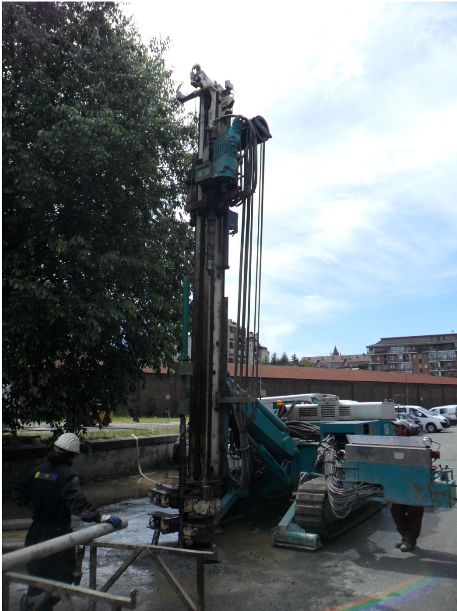
Esecuzione prove S.P.T. Postazione S.4
