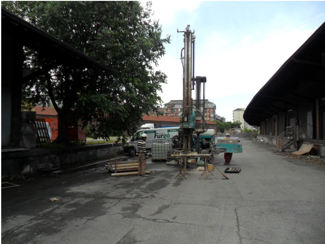
Sonda perforatrice Casagrande C6. Postazione S.4
