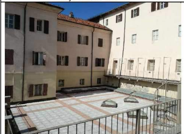
Copertura biblioteca CAI
