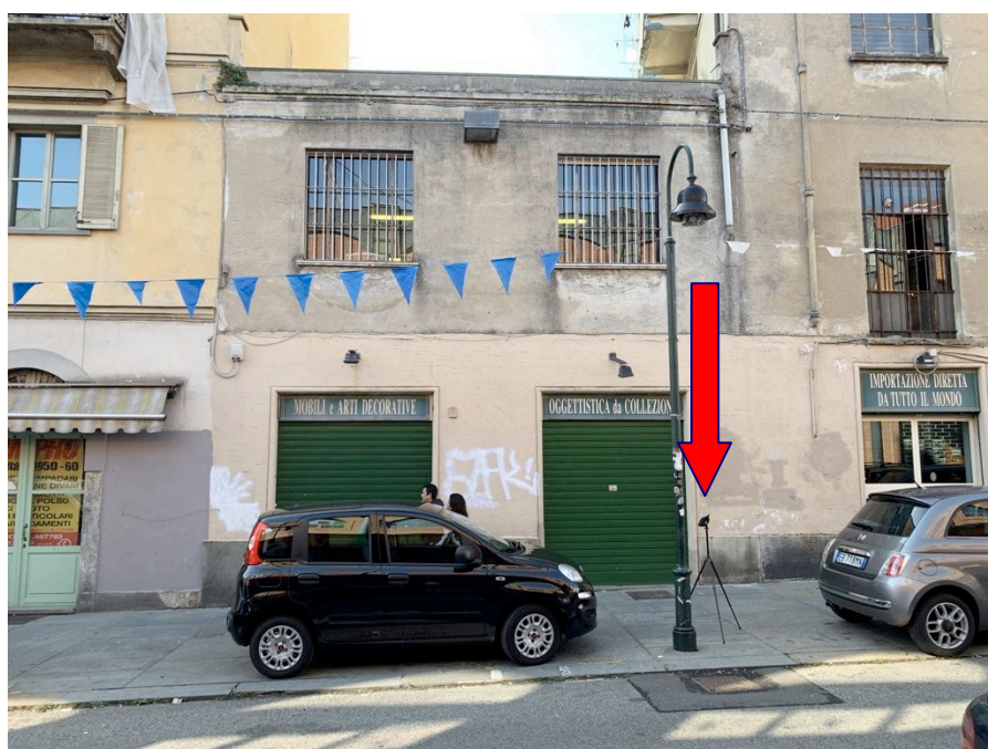
Vista del punto di misura B
