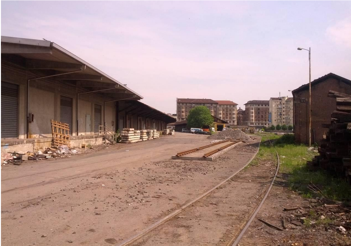
Vista da SUD area di futura edificazione edificio CIRP
