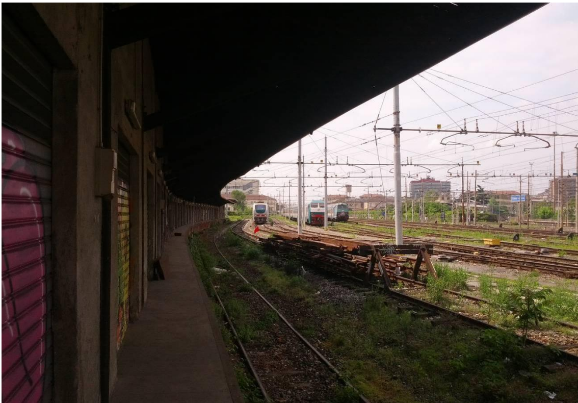
Punto di controllo C1 monitoraggio in continuo
