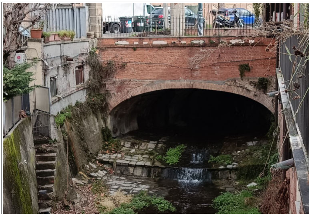
Figura 29 - Esempio di tratto intubato.
