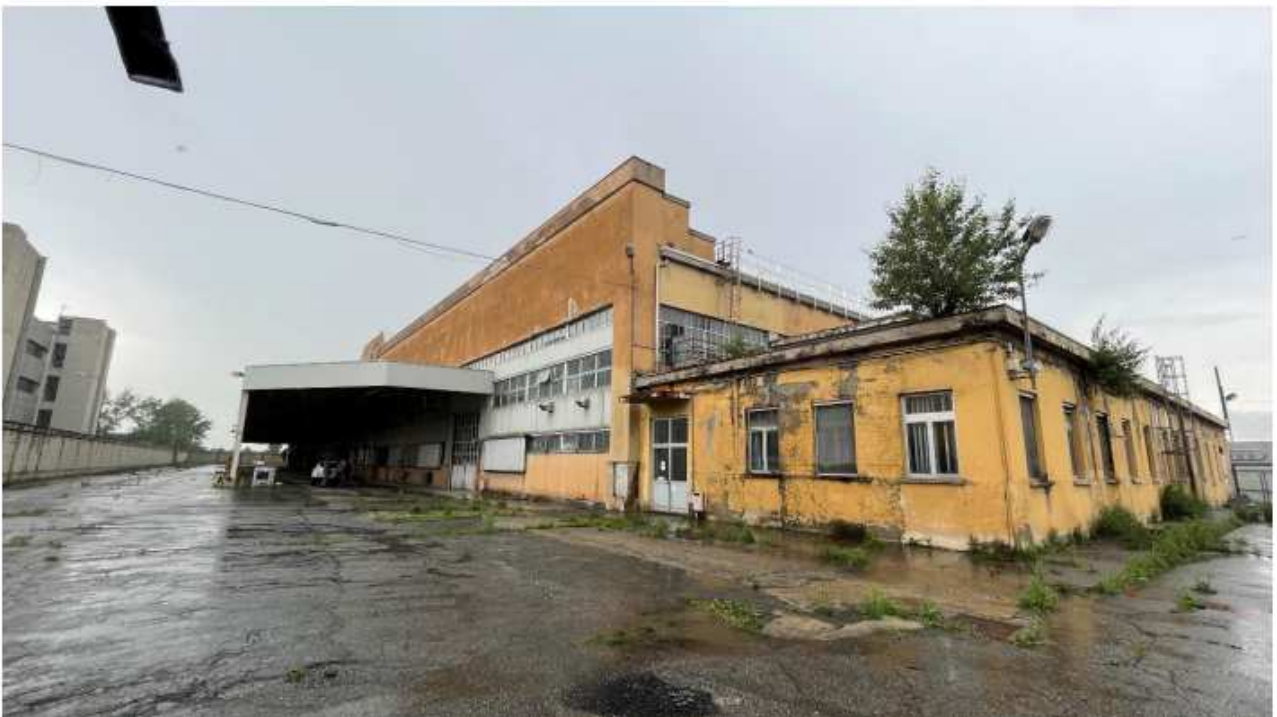
Vista interna fabbricato angolo Sud - Ovest
