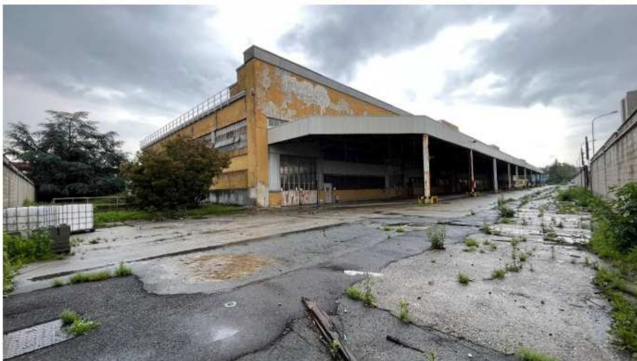
Vista interna fabbricato angolo Nord - Ovest
