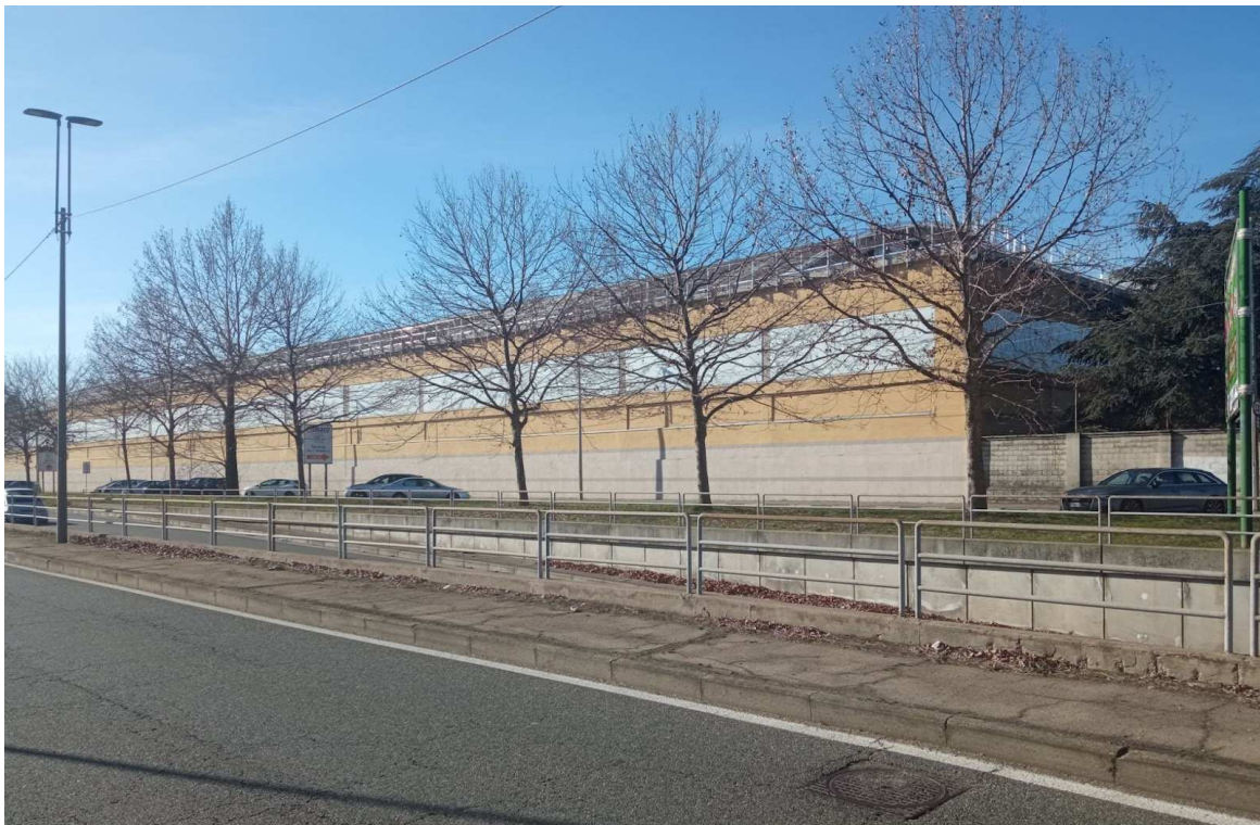
Vista angolo fabbricato - Nord - Est
