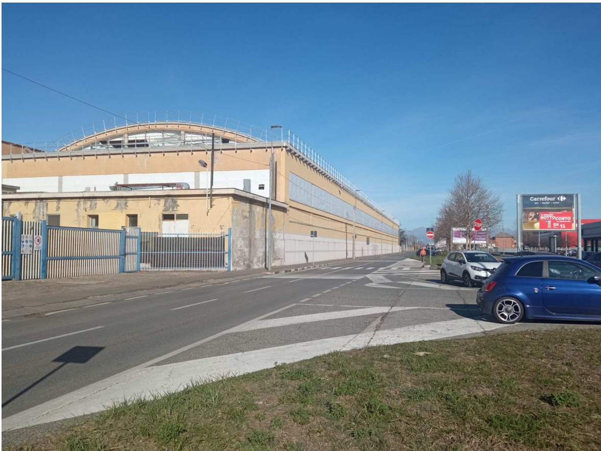
Vista facciata fabbricato - lato Corso Marche
