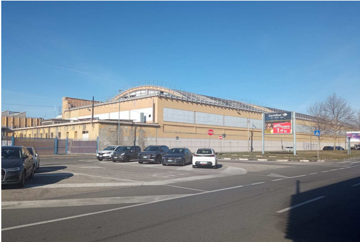
Vista angolo fabbricato - Sud - Est
