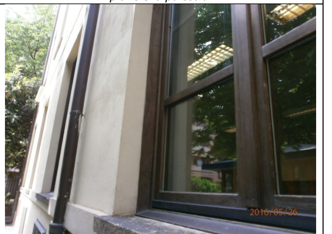
Dettaglio serramenti esistenti (di recente sostituzione)
