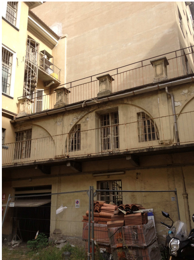
Vista interno cortile lato via Corte d'Appello 14
