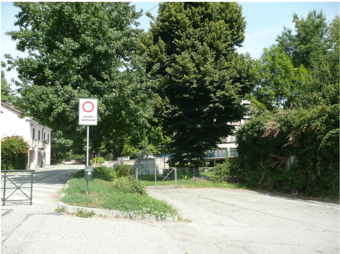
Vista imm.le lato via S. Sebastiano Po
