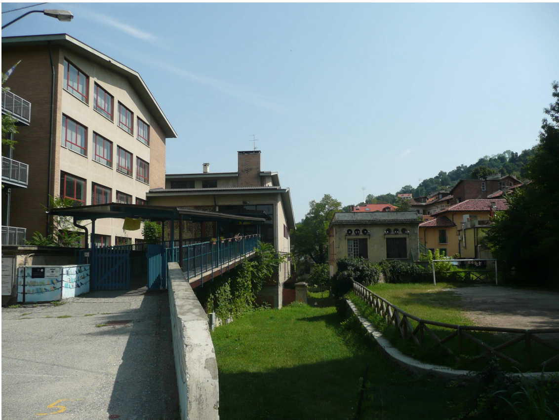
Vista imm.le lato via S. Sebastiano Po
