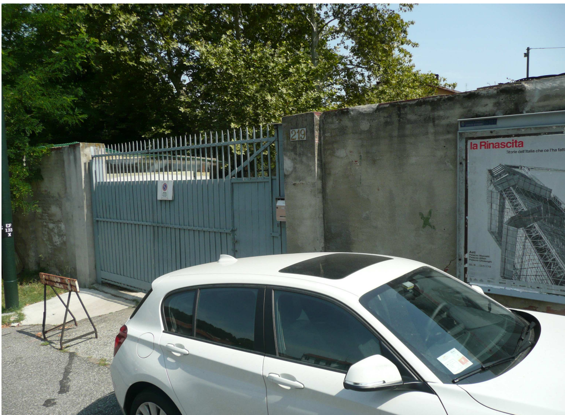
Vista imm.le lato via S. Sebastiano Po
