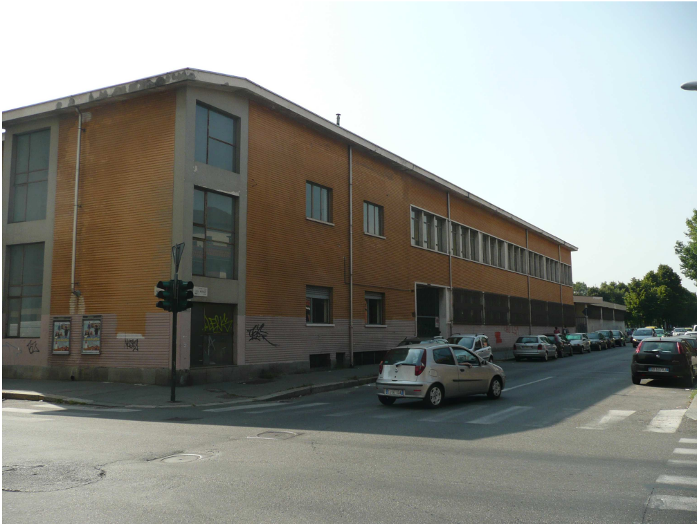
Vista lato via Marsigli ang. via Bardonecchia
