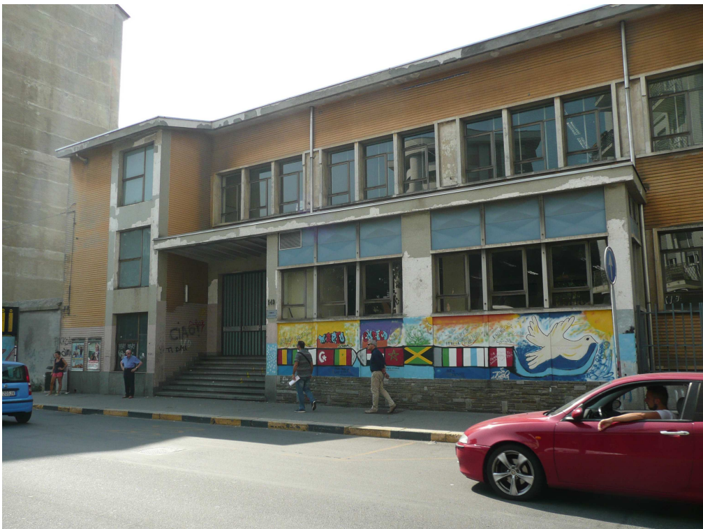
Vista ingresso imm.le in via Bardonecchia 151
