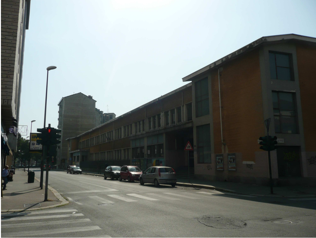
Vista lato via Bardonecchia ang. via Marsigli
