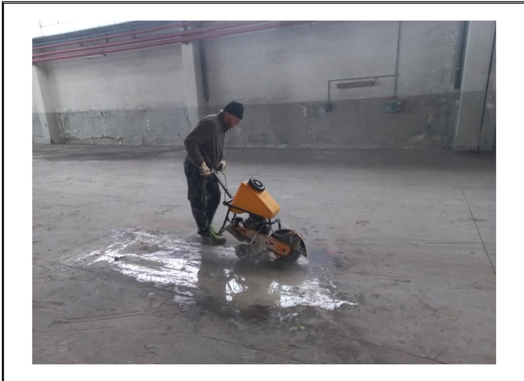
**Foto 11:** Fase di taglio pavimentazione Pozzetto P1.
