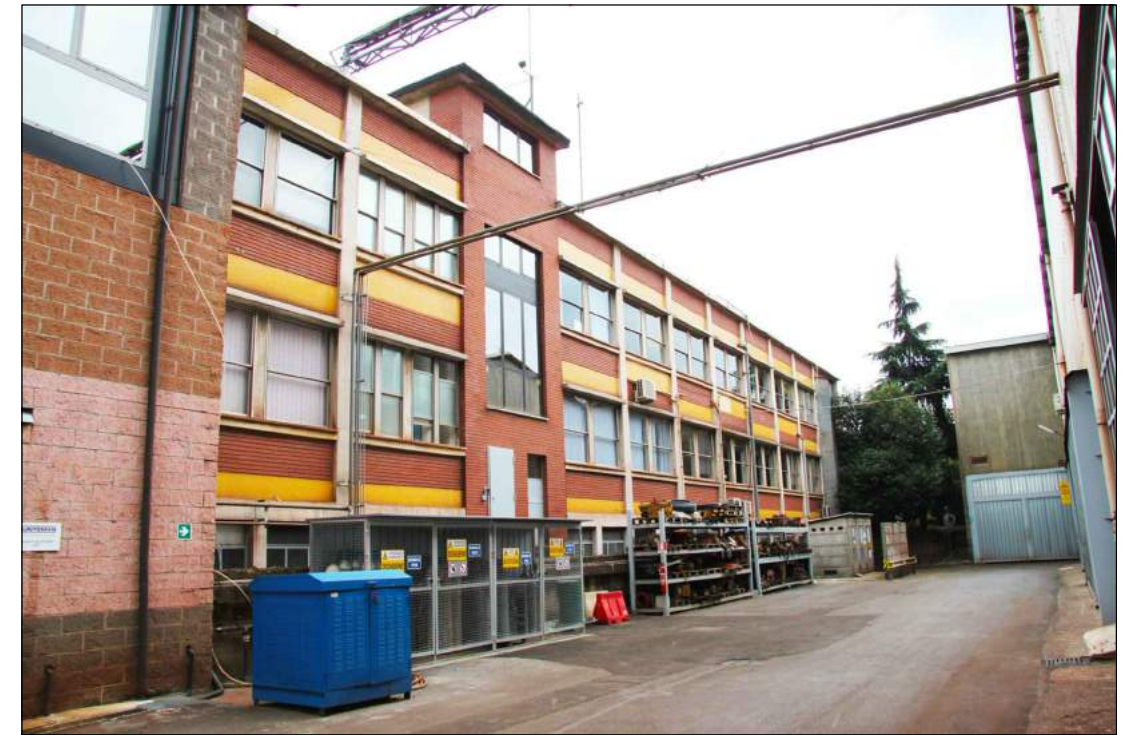
2 PALAZZINE UFFICI - VISTA ESTERNA Lato produzione
