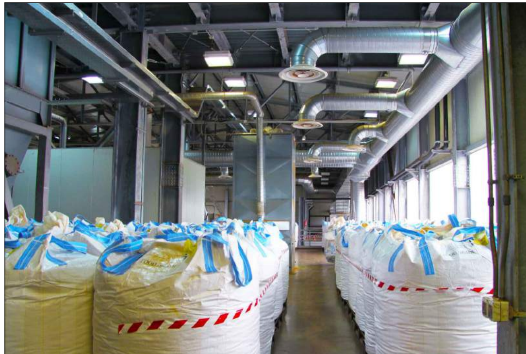
3 EDIFICIO ALTA PUREZZA - VISTA INTERNA Impianti di produzione
