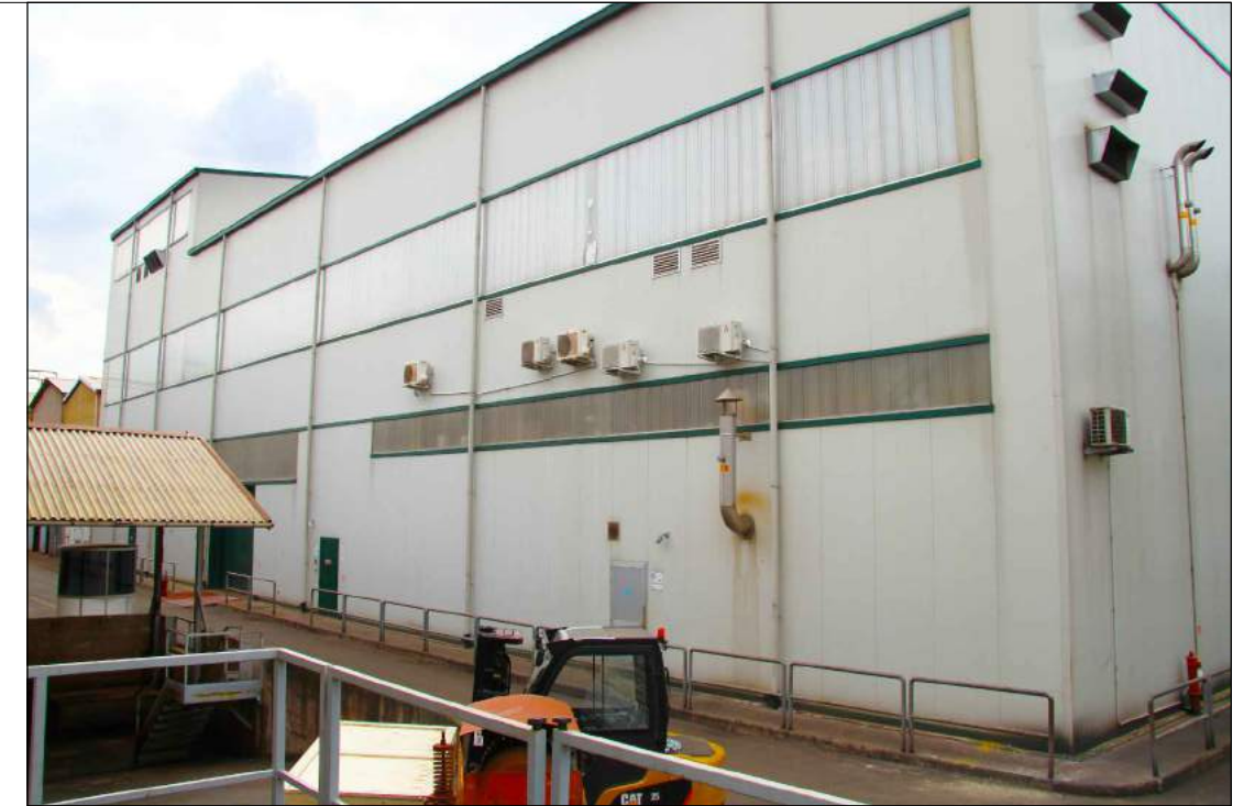
2 EDIFICIO ALTA PUREZZA - VISTA ESTERNA Dall'ingresso area spogliatoi
