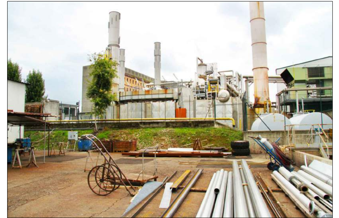
2 CENTRALE DI COGENERAZIONE - VISTA ESTERNA Centrale di cogenerazione
