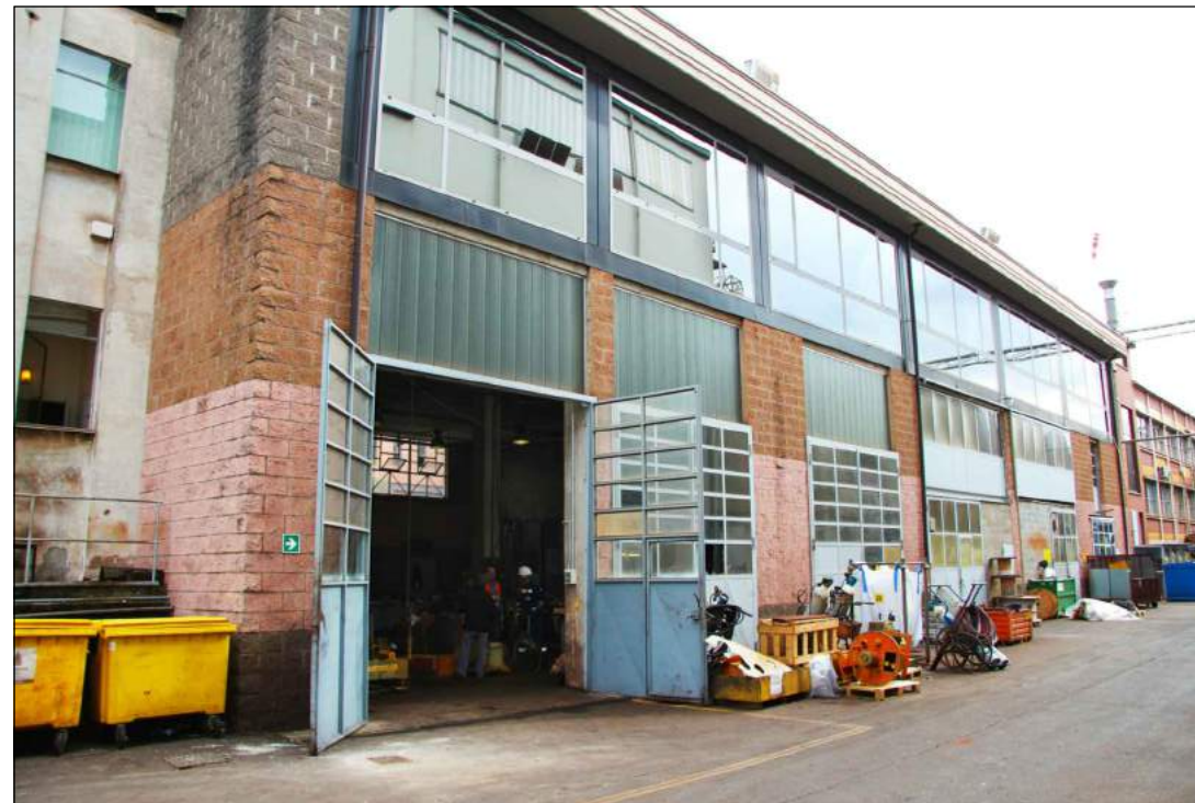
3 PALAZZINE UFFICI - VISTA ESTERNA Ingresso officine meccaniche
