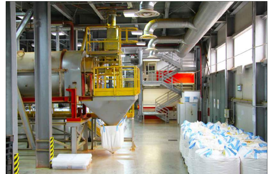
4 EDIFICIO ALTA PUREZZA - VISTA INTERNA Scale interne d'accesso agli uffici
