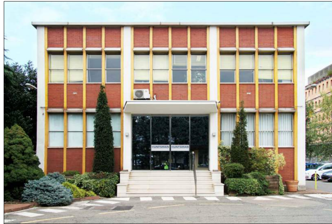
1 PALAZZINE UFFICI - VISTA ESTERNA Ingresso principale
