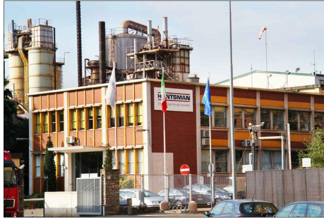
1 PALAZZINE UFFICI - VISTA ESTERNA Ingresso principale
