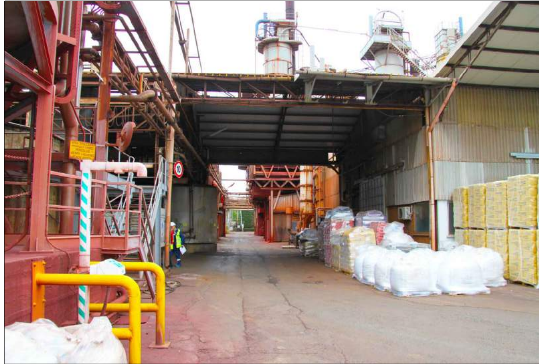
1 EDIFICI PRODUZIONE - VISTA ESTERNA Vista laterale edificio insacchi
