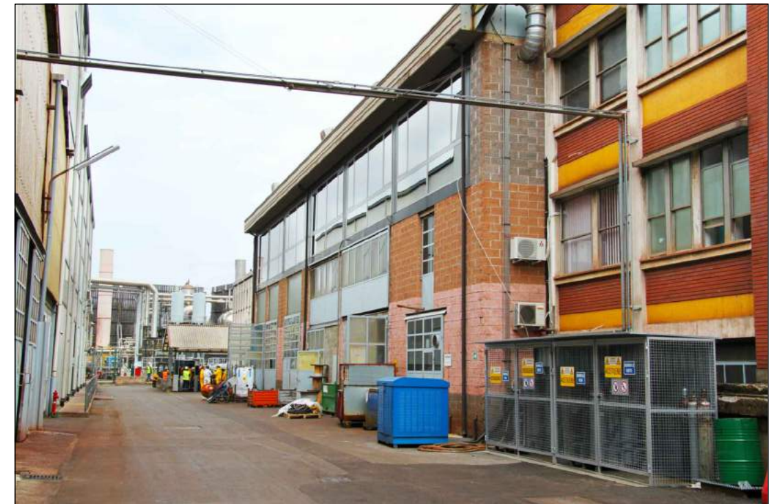
4 PALAZZINE UFFICI - VISTA ESTERNA Continuità palazzine uffici
