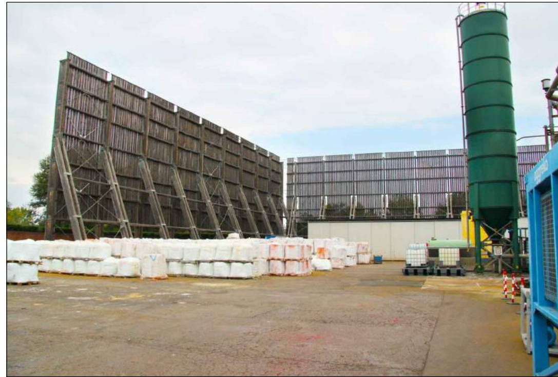
1 MAGAZZINI|STOCCAGGIO - VISTA ESTERNA Area magazzini stoccaggio all'aperto
