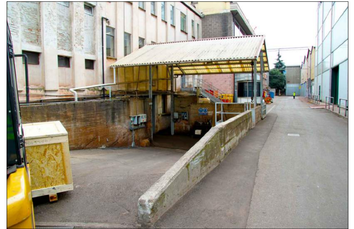
6 PALAZZINE UFFICI - VISTA ESTERNA rampa officine meccaniche
