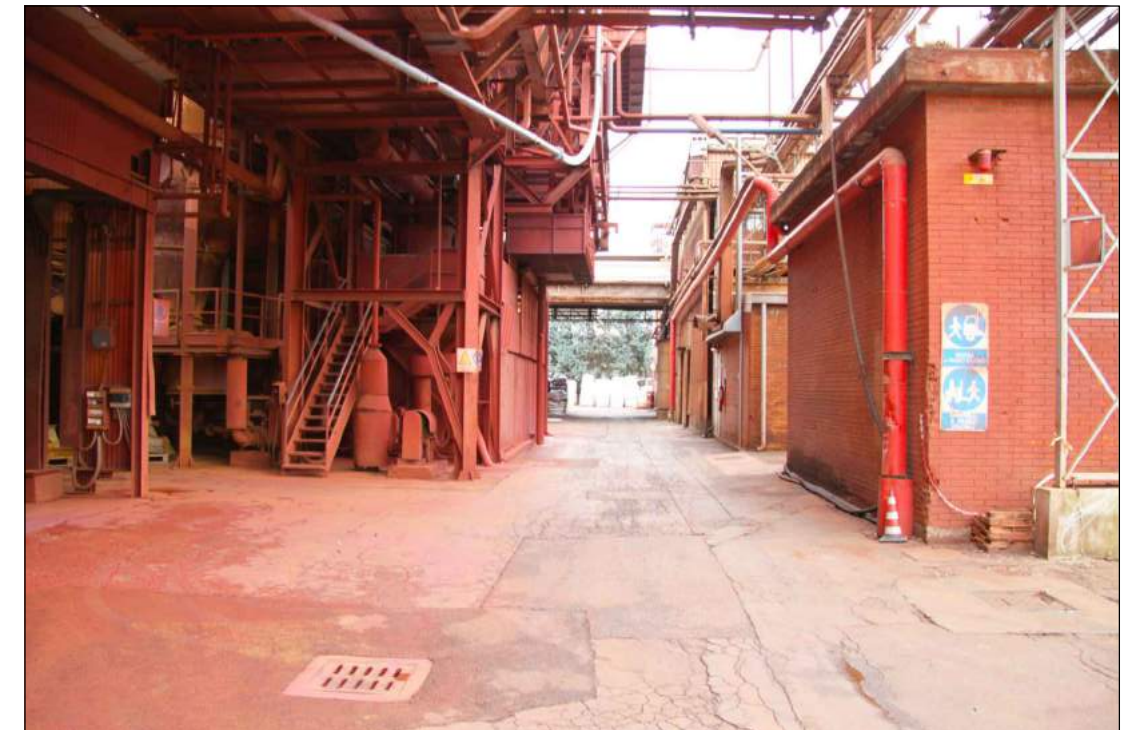
4 EDIFICI PRODUZIONE - VISTA ESTERNA Percorsi tra gli edifici della produzione
