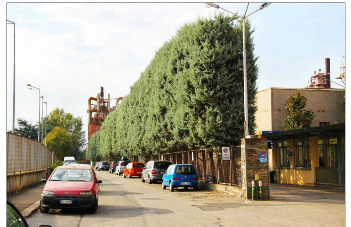
4 PALAZZINE UFFICI - VISTA ESTERNA Guardiania e recinzione verso Poste Italiane
