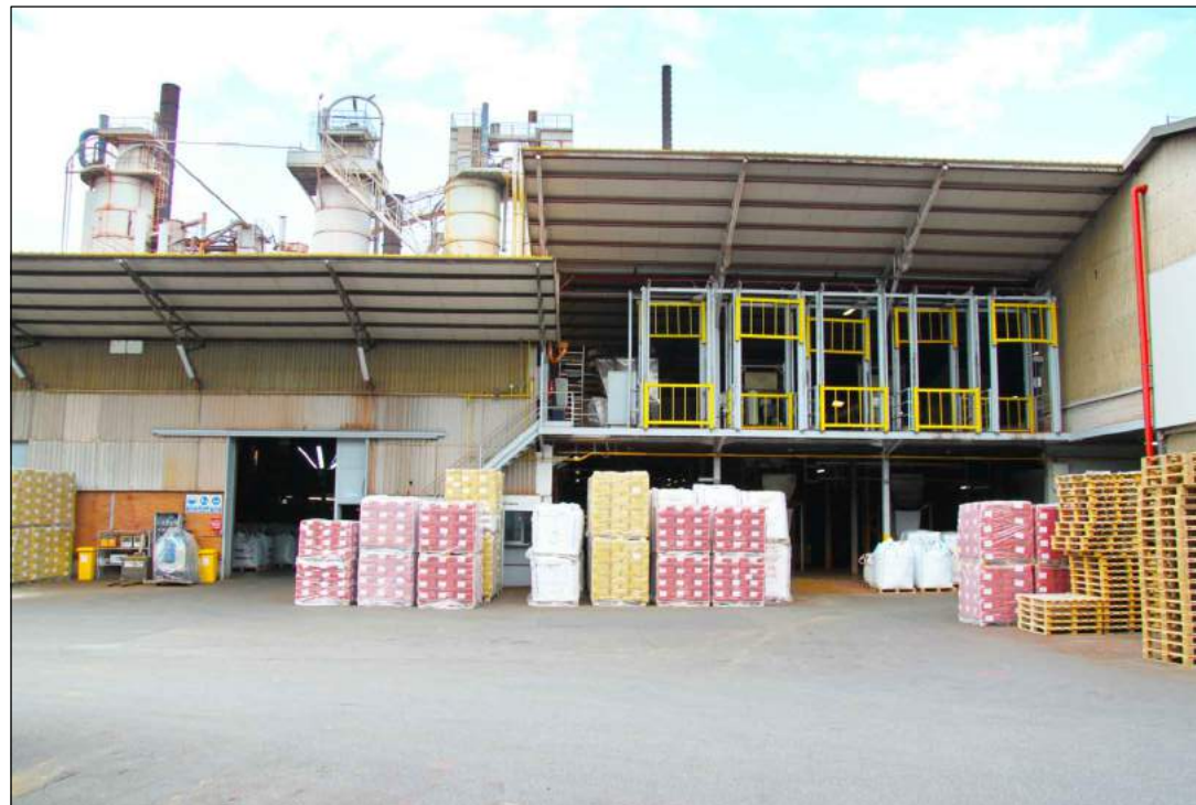
3 EDIFICI PRODUZIONE - VISTA ESTERNA Accesso magazzino alta purezza
