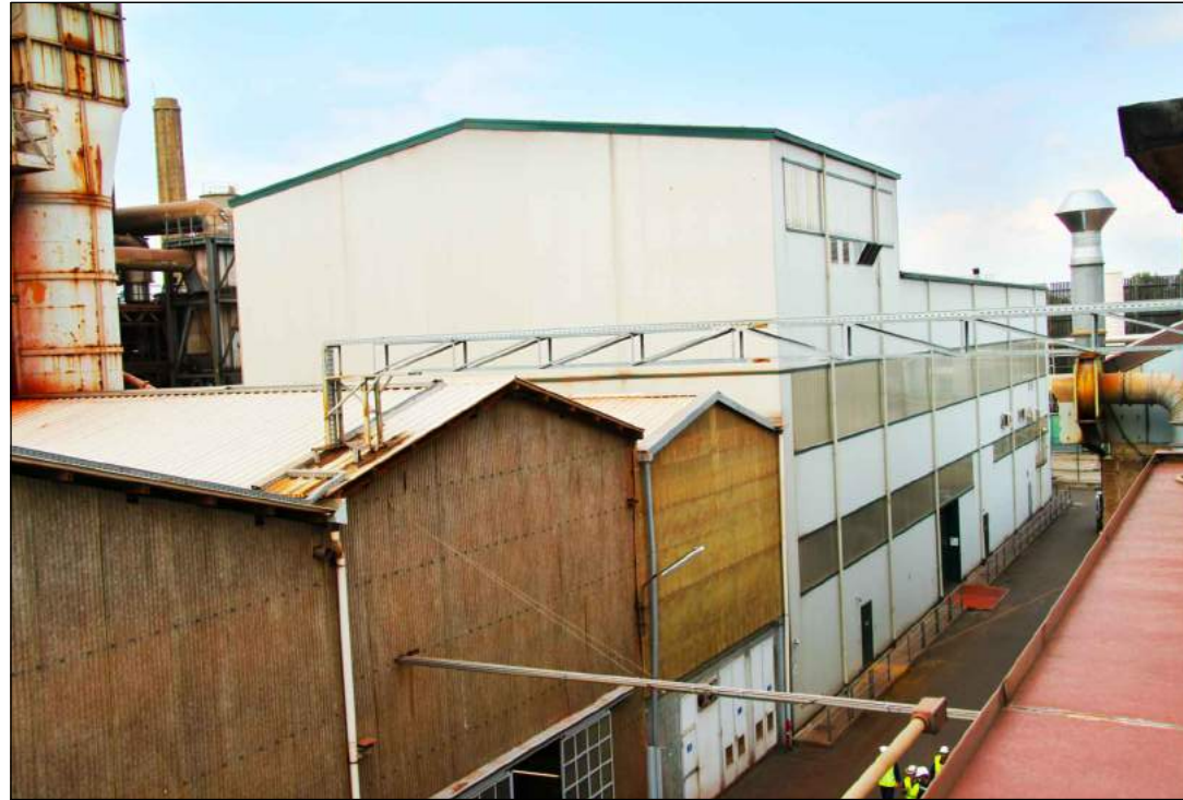
1 EDIFICIO ALTA PUREZZA - VISTA ESTERNA Dalla copertura della palazzina uffici amministrativi
