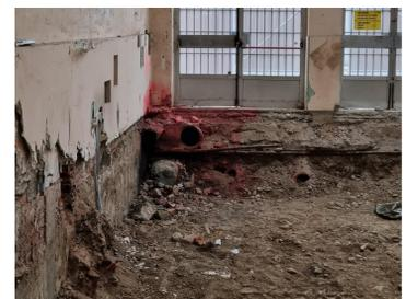
[1.2] RIMOZIONE TUBAZIONE IN FIBROCEMENTO
