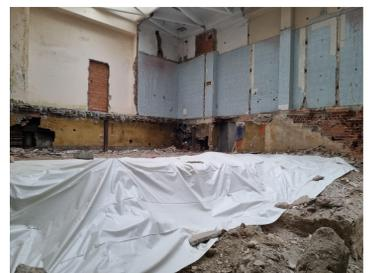
[1.3] RIMOZIONE CUMULO DI TERRA CON FRAMMENTI IN FIBROCEMENTO
