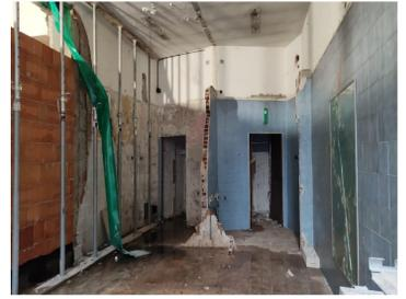
[3] DEMOLIZIONE BLOCCO BAGNI ESISTENTE (FINO A QUOTA TERRENO DI POSA FONDAZIONI)
