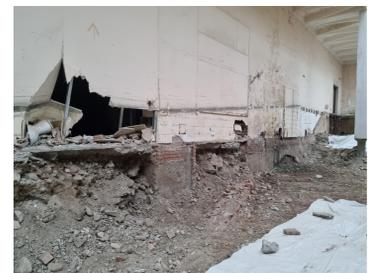
[7] DEMOLIZIONE E RICOSTRUZIONE MURATURA DI SEPARAZIONE TEATRO NUOVO/GALLERIA
