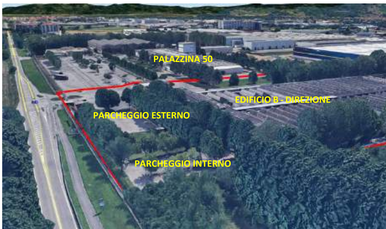
Figura 18 – Area antistante l'edificio Direzione
