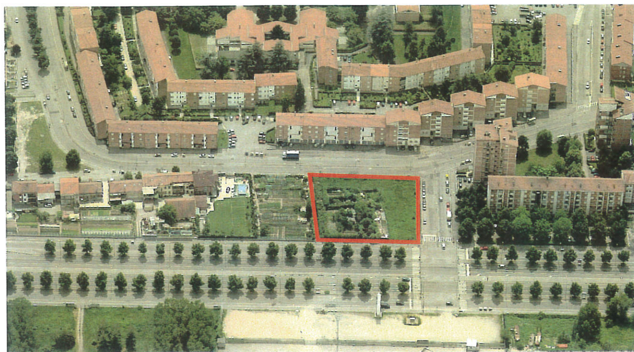
Vista aerea da nord
