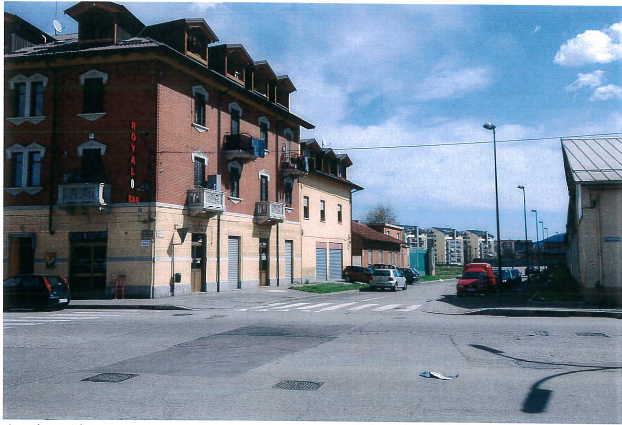
vista 4 - edificio esistente ambito "5.6 - RUBBERTEX 1", sub ambito 3, via Ala di Stura angolo via Massari
