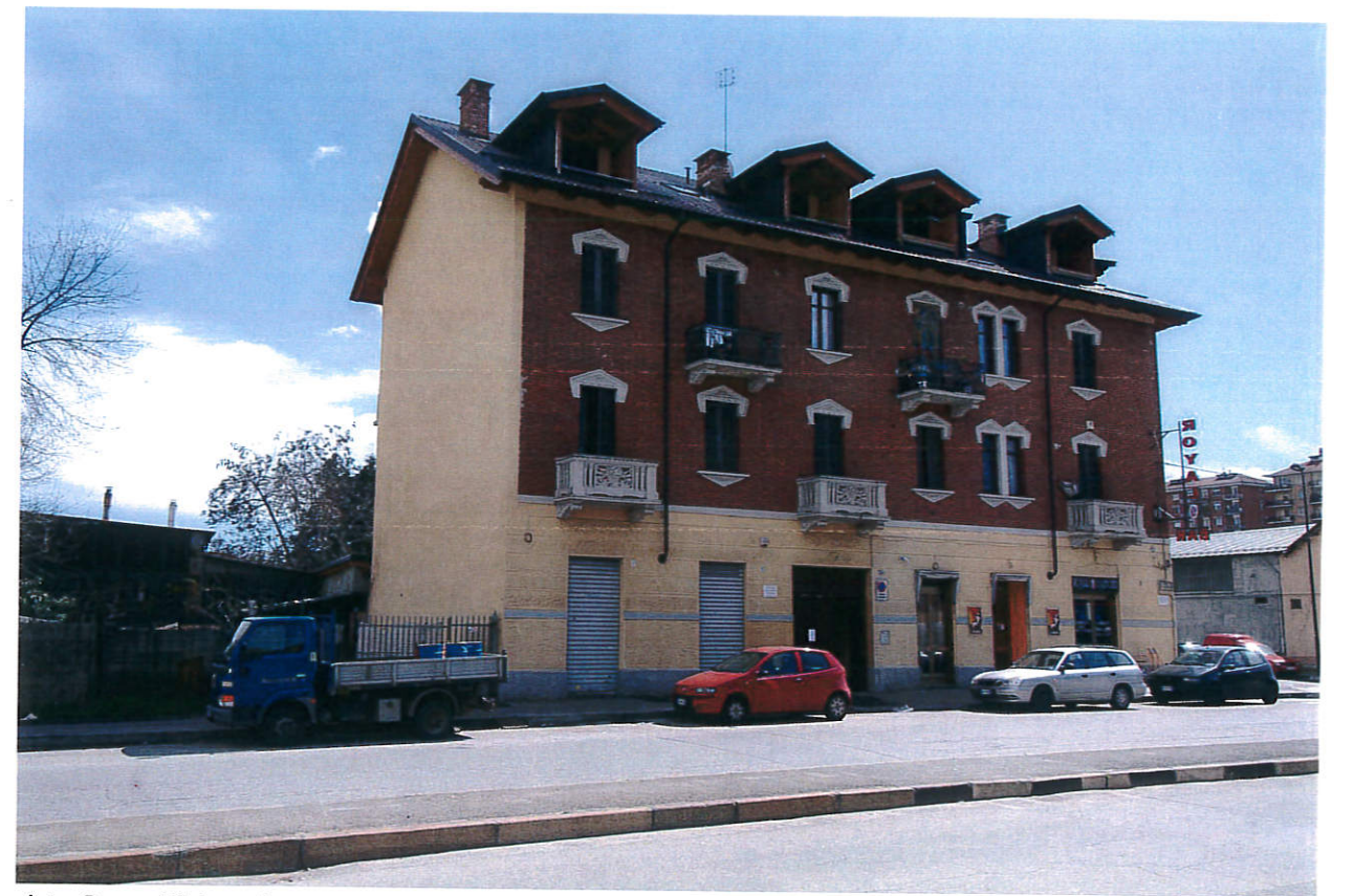
vista 3 - edificio esistente ambito "5.6 - RUBBERTEX 1", sub ambito 3, via Ala di Stura
